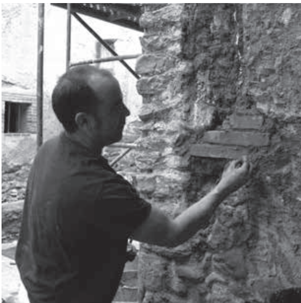
Taller dut a terme a Monells. Mòdul 3: La terra i la ceràmica. UEC 2a edició. Restauració d'una façana de tàpia.
