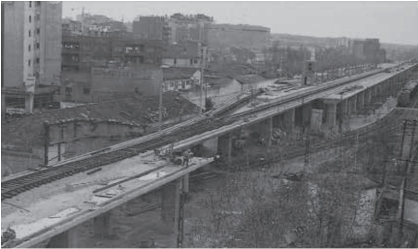
Evolució de les obres del viaducte (1972). CRDI. Fotografia de Jufer F. Morente.
