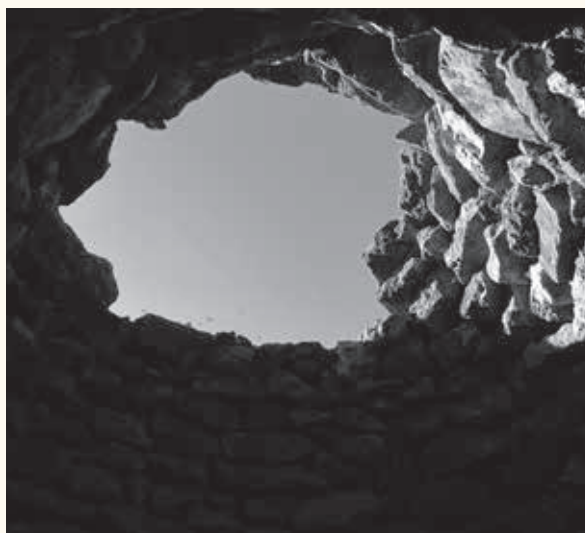
Falsa volta en una barraca de pedra seca. M1 pedra. Escola Sert.
