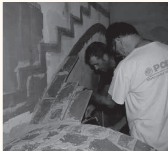
Construcció d'una volta de mocador i d'una volta d'escala, al centre de Formació de la UEC, de la mà del Mestre en volta Ramon Gurada. M3 ceràmica i terra UEC.
