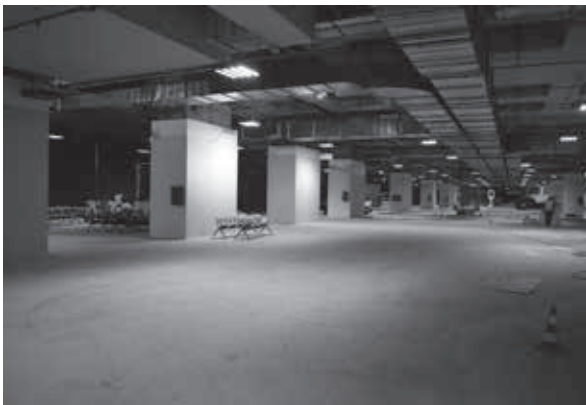
Obres interiors de l'estació (28-3-2017). Fotografia de Josep M. Arjona i Borrego.
