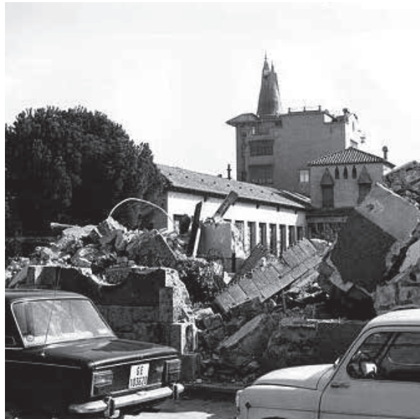
1973/08/27. Les restes dels xalets Teixidor, obra de l'arquitecte Rafael Masó, vistes des del carrer Ibèria i des del carrer Santa Eugènia. Foren enderrocats il·legalment la matinada del 27 d'agost del 1973, quan s'estava tramitant la seva inclusió al catàleg d'edificis d'interès històric-artístic. Al fons, la Casa Teixidor, coneguda popularment com La Punxa. Ajuntament de Girona. CRDI (Autor desconegut)
