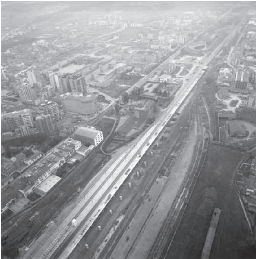
Vista aèria de l'evolució de les obres del viaducte (1973). CRDI. Fotografia de Narcís Sans Prat.
