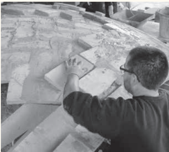
Construcció d'una volta de mocador i d'una volta d'escala, al centre de Formació de la UEC, de la mà del Mestre en volta Ramon Gurada. M3 ceràmica i terra UEC.
