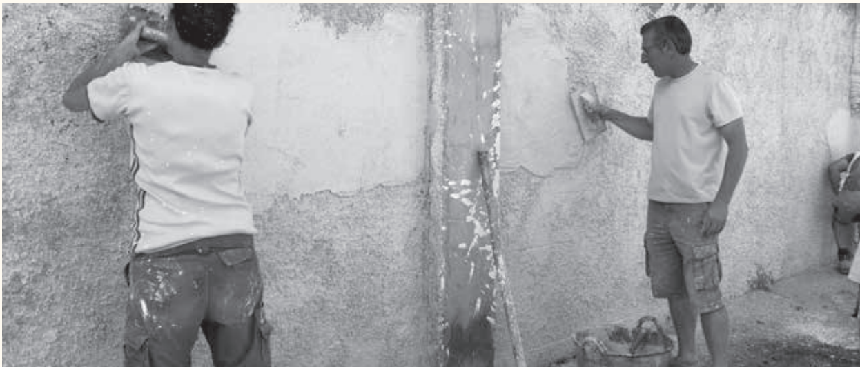
Lliscat de morter de calç sobre esquerdejat, a les instal·lacions de la UEC a Palol de Revardit. M2 calç UEC.
