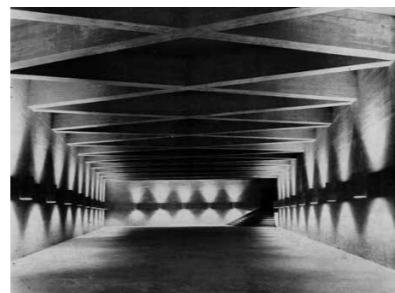
Sala a l'estrep dret amb l'escala d'accés en una de les cantonades. Fotografia Brangulí. REBOLLO ALONSO, 1974, p. 102.
