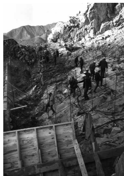
Execució dels treballs de neteja de la roca en la fonamentació del primer bloc. Fondo Histórico. Fundación Endesa.
