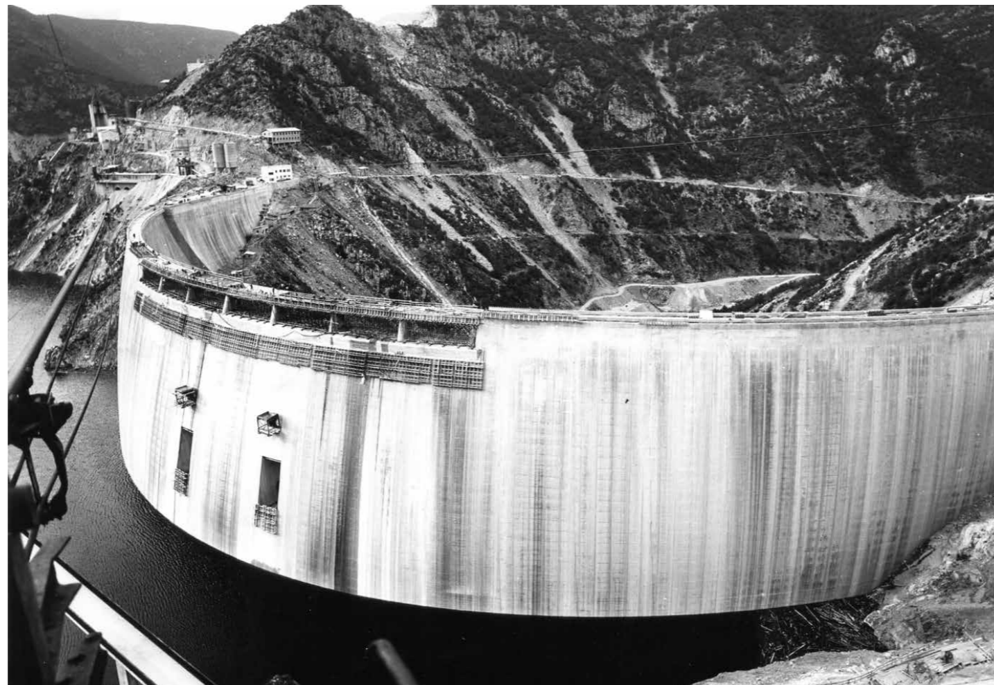
Vista general de l'estat més avançat de la construcció de la presa. Fondo Histórico. Fundación Endesa.
