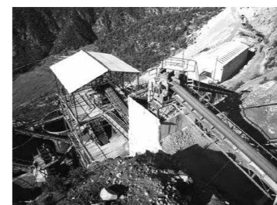
Vista general de les instal·lacions de matxuqueig i de classificació d'àrids. Fondo Histórico. Fundación Endesa.
