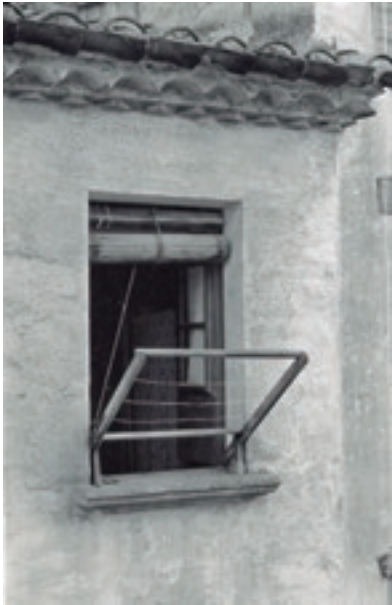
Ràfec amb tortugada i finestra amb estenedor de roba.
