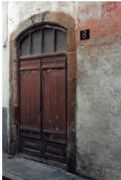
Portalada formada per un arc de pedres adovellades.
