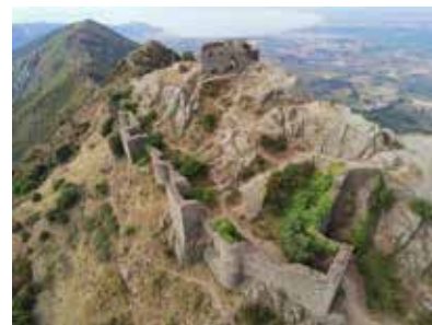
Vista aèria de la part de muralla més ben conservada. Al fons, la badia de Roses.
