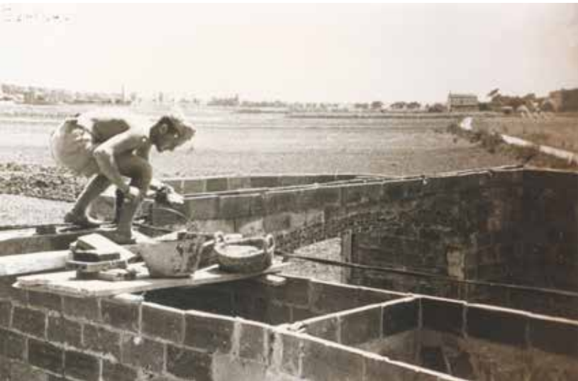
Construcció de la casa del Sr. Gascon (autor de les fotografies) el 1948.
