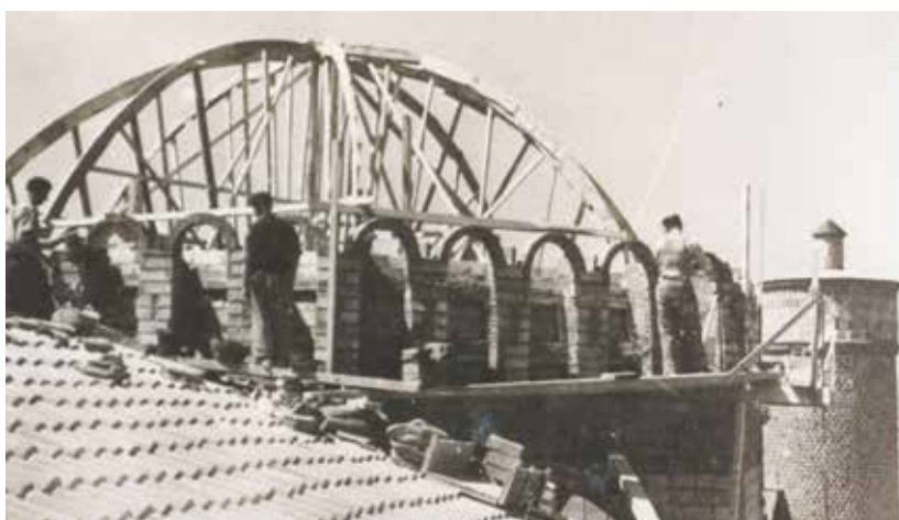
Forjat de la primera planta amb les voltes tapades amb terra volcànica.
