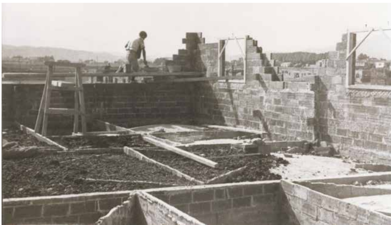
Forjat de la primera planta amb les voltes tapades amb terra volcànica.
