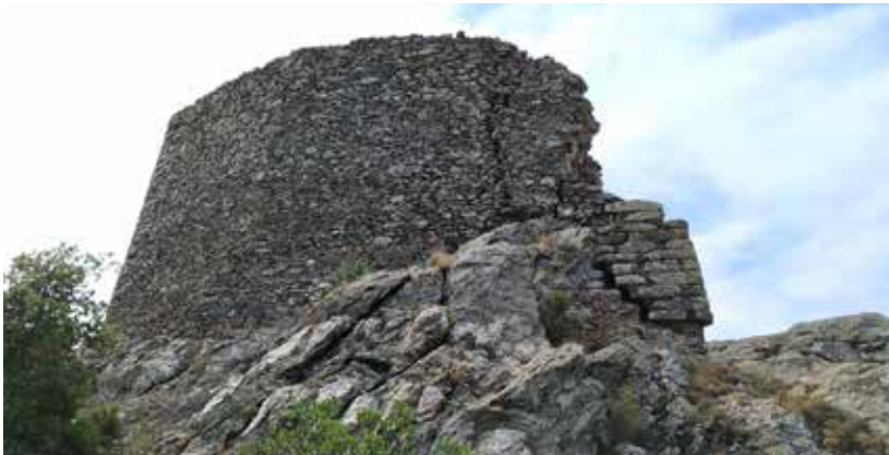
Torre triangular. S'aprecia la part malmesa.
