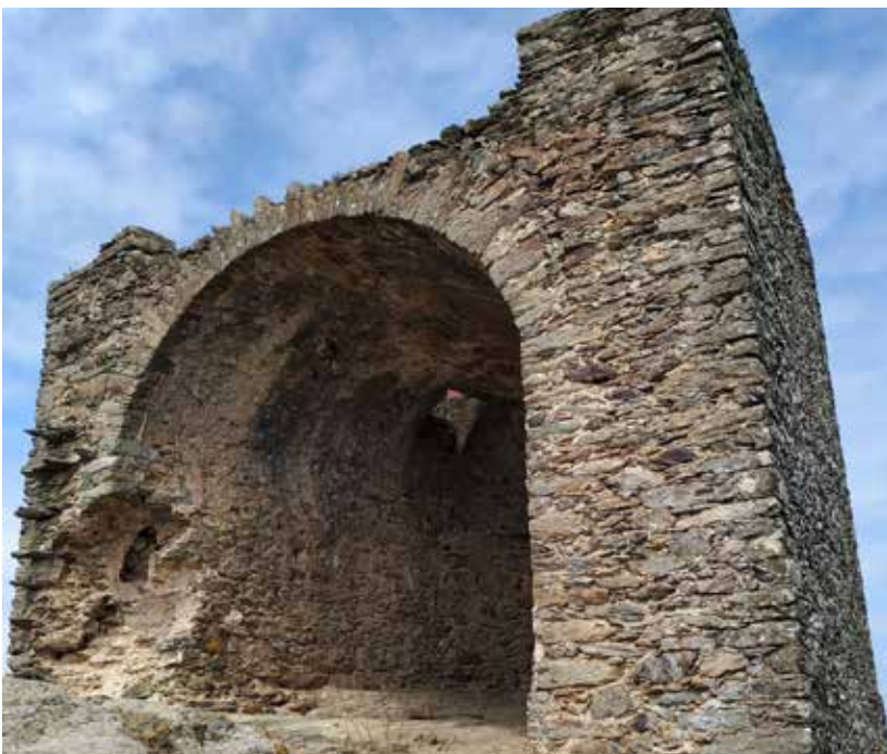
Vista de la torre per l'interior i volta amb l'obertura per accedir a la coberta.
