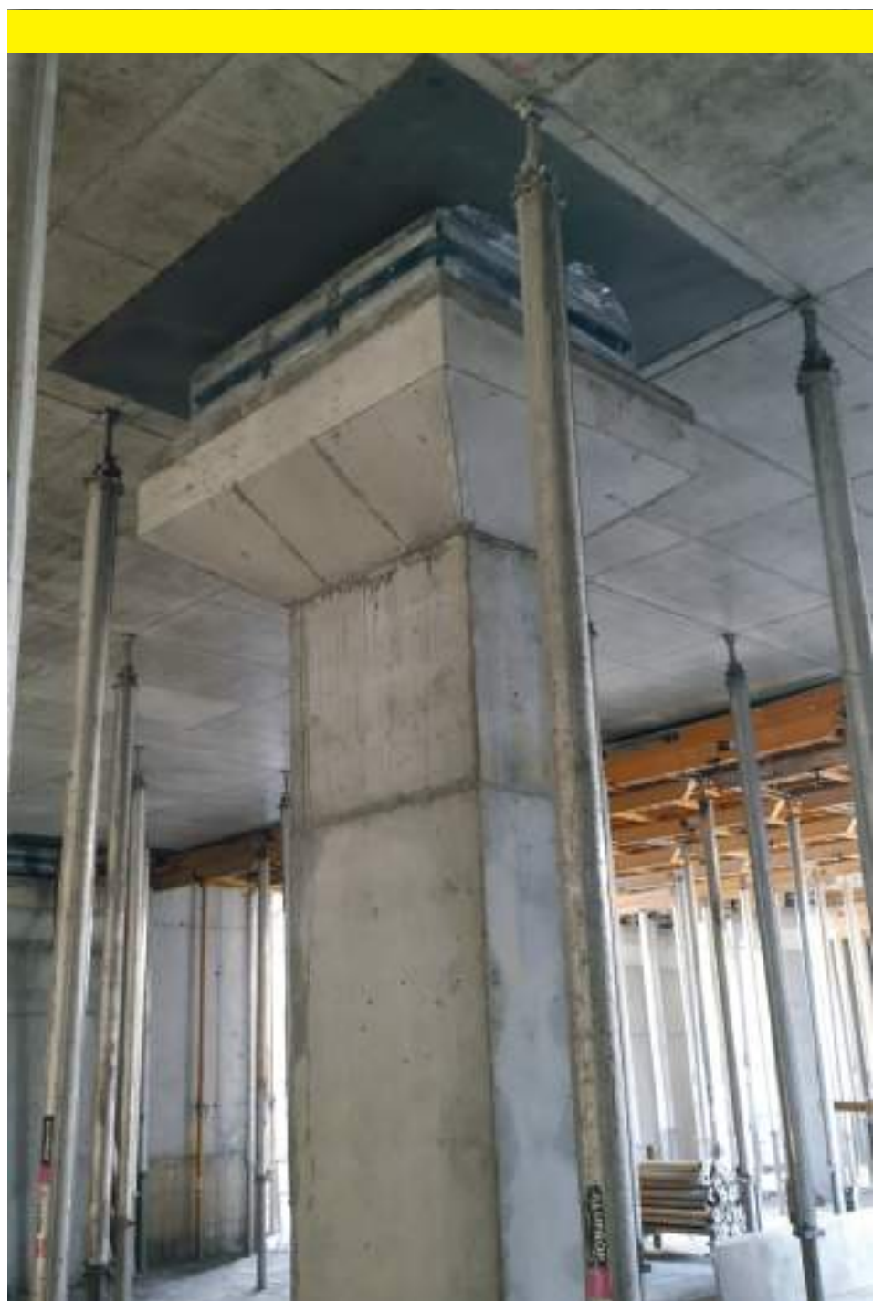
► Modelització de les molles en BIM i execució pilar amb molla
