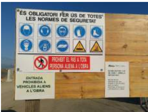
Senyalització, tractament dels residus i control d'accessos a obra
