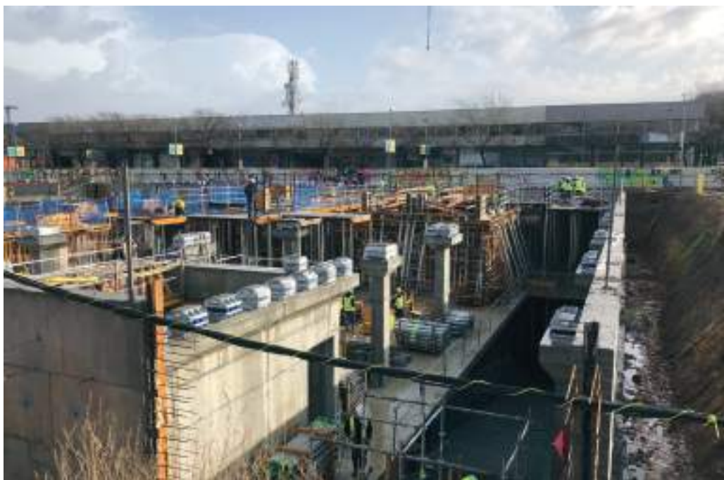
Clínica Girona, foto d'obra I: col·locació de les molles com a element estructural
