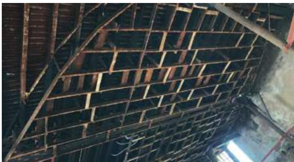
Vista general de la coberta a l'estudi històric Fotografia: Maribel Fuertes Avellaneda
