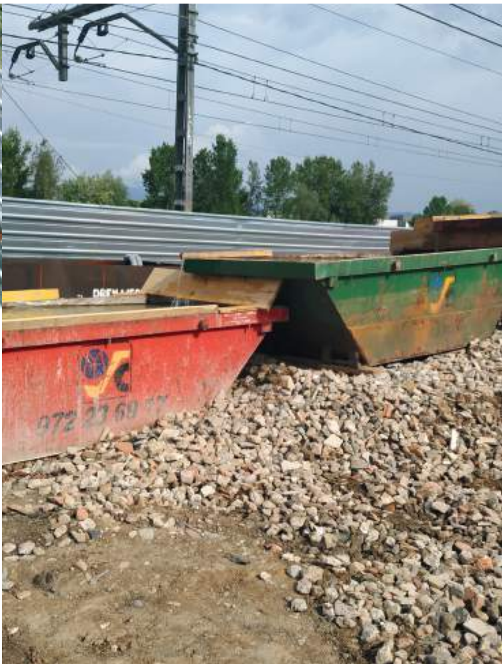
▲ Dipòsit de decantació per a l'aigua del subsol
