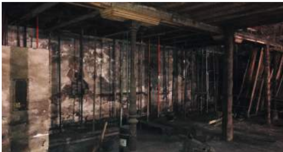
Sota de la tarima de fusta amb pilars de fosa Fotografia: Josep M. Arjona i Borrego
