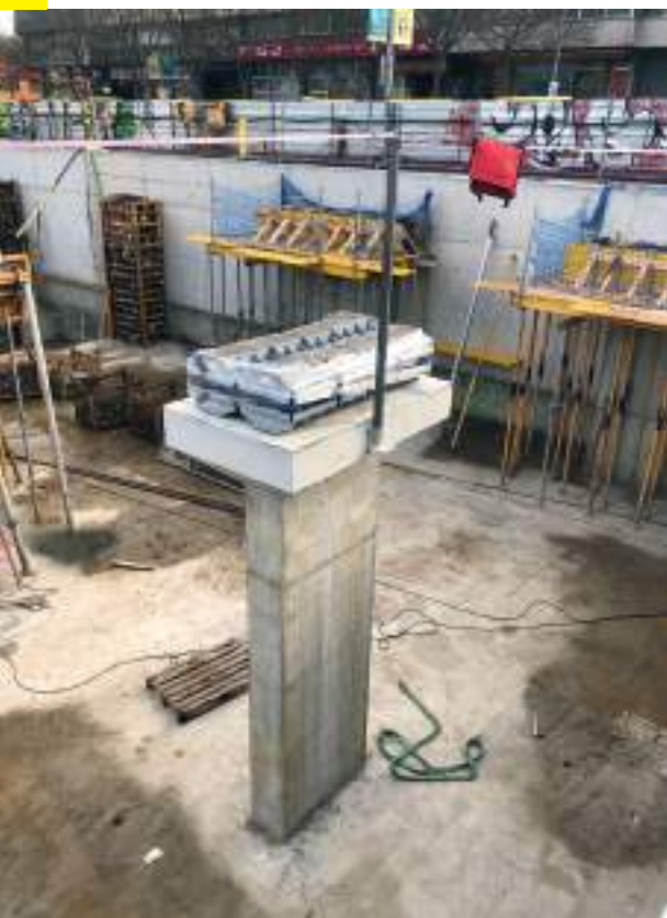
◀ Clínica Girona, foto d'obra I: col·locació de les molles com a element estructural
