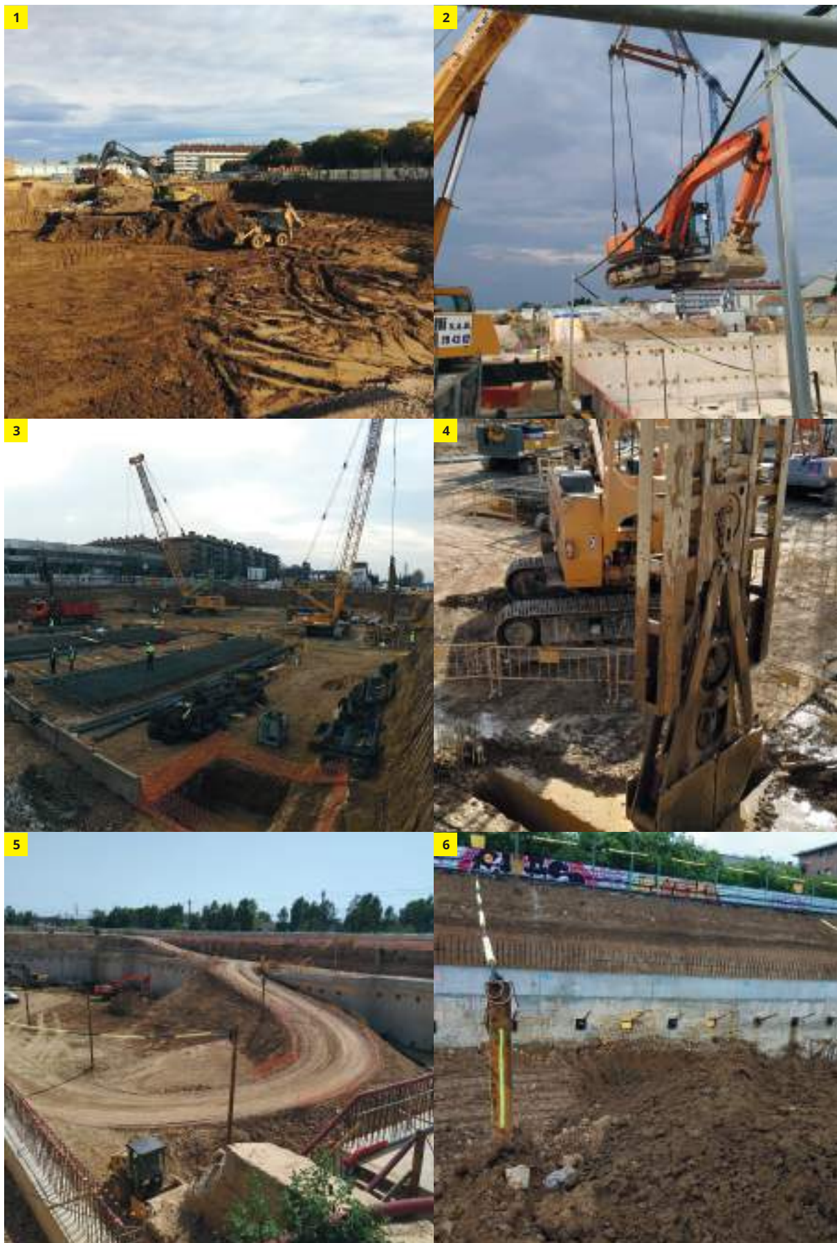
1. Excavació a la cota de base de la llosa 2. Extracció de la màquina d'excavació 3. Execució de les pantalles i els armats
