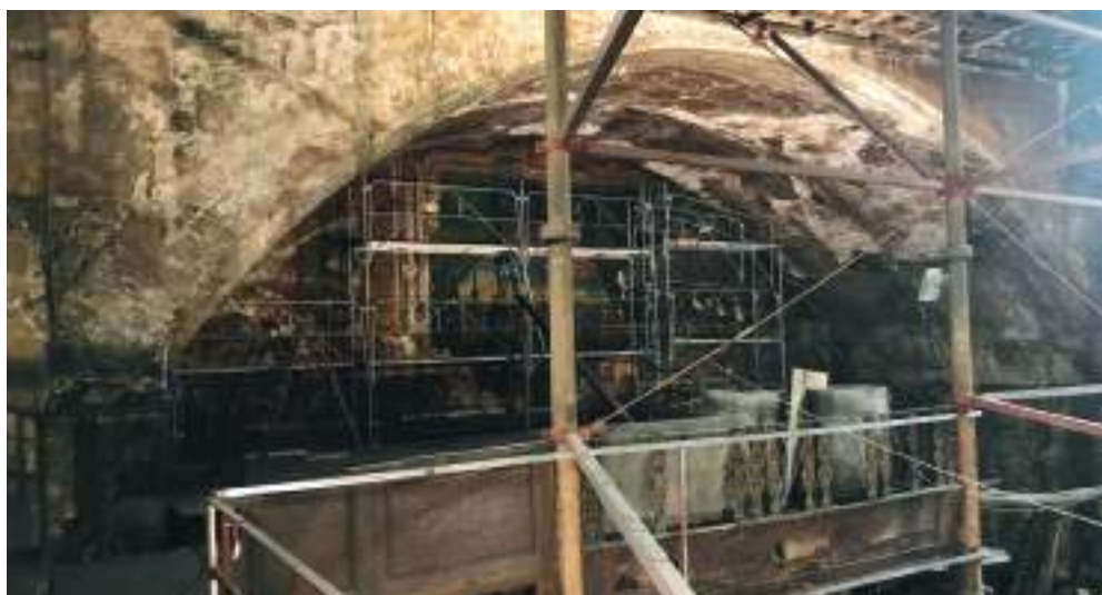
Vista general de tot el sistema estructural Fotografia: Josep M. Arjona i Borrego
