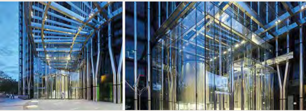
Entrada de la Torre Europa
