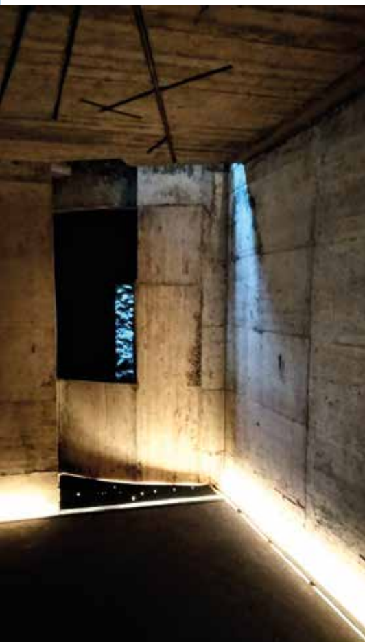
Entrada de llum natural indirecta al soterrani (fotografia: P. A.)
