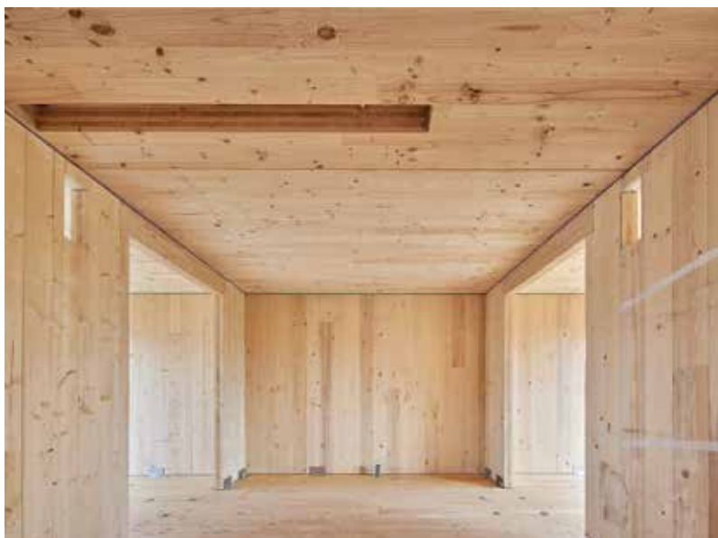
Estructura de panells de CLT
