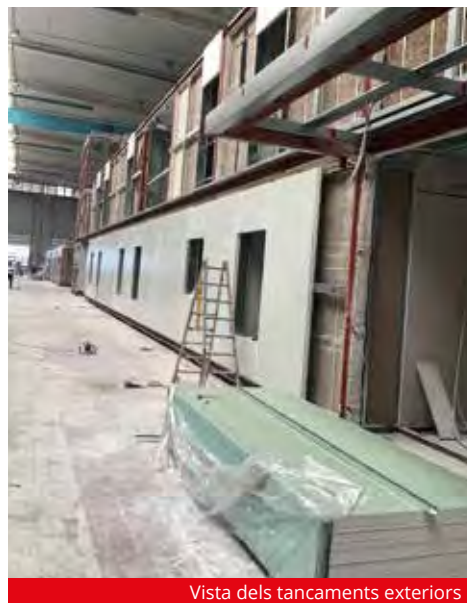
Vista dels tancaments exteriors
