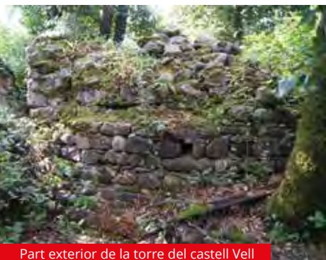
Part exterior de la torre del castell Vell de Brunyola
