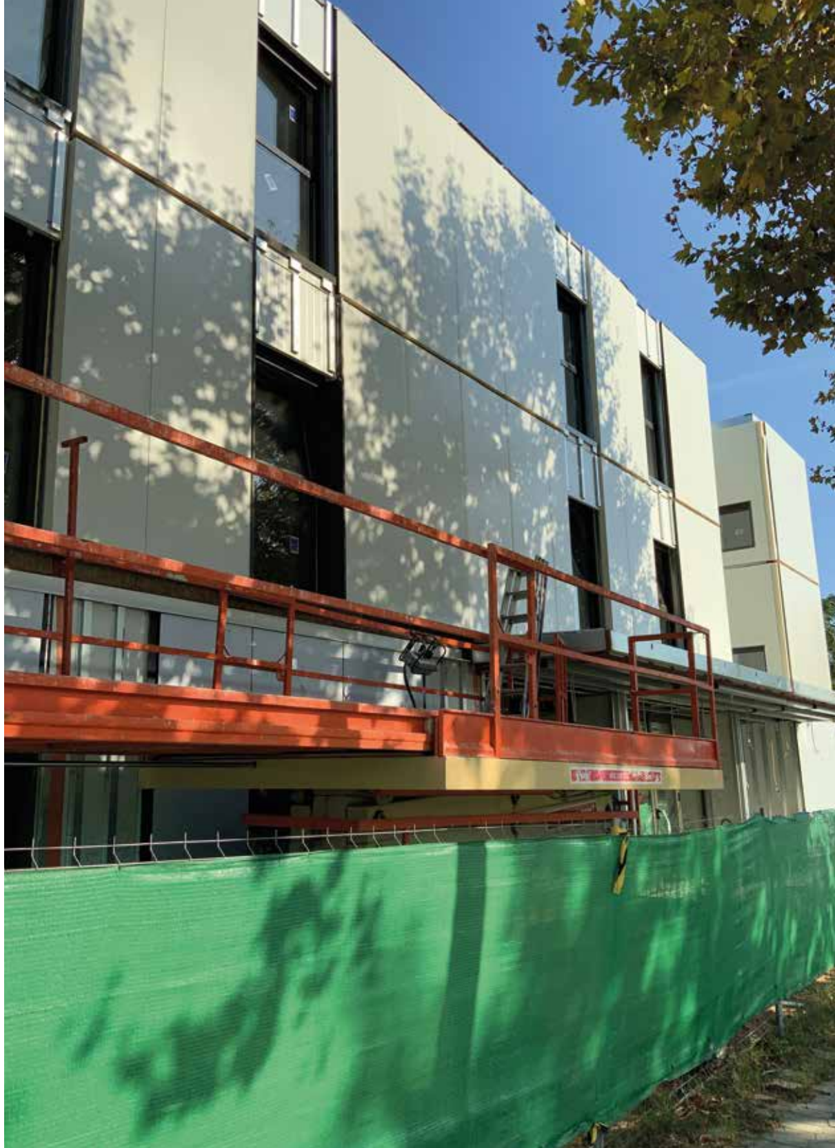
Façana de l'edifici muntat in situ
