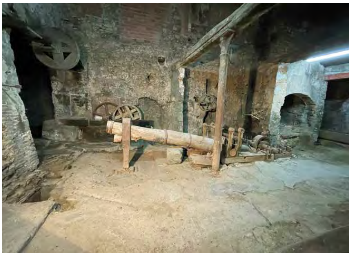
Vista del martinet actual.
