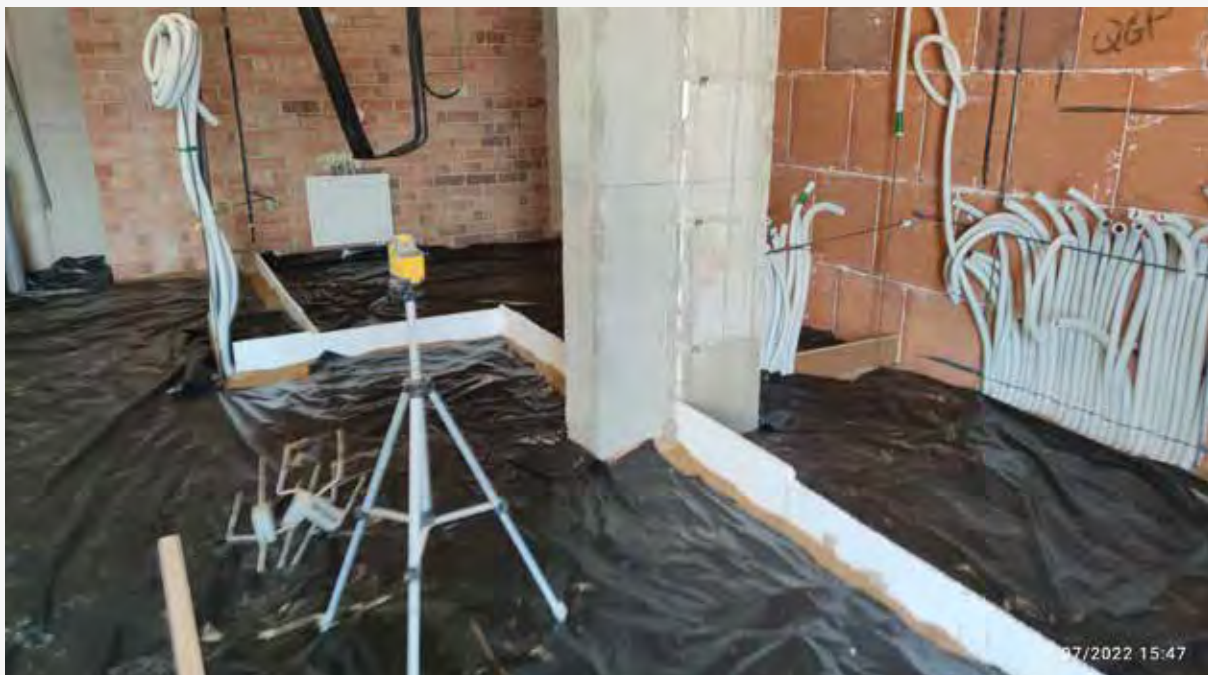
Nivell làser utilitzat per anivellar paviments.
