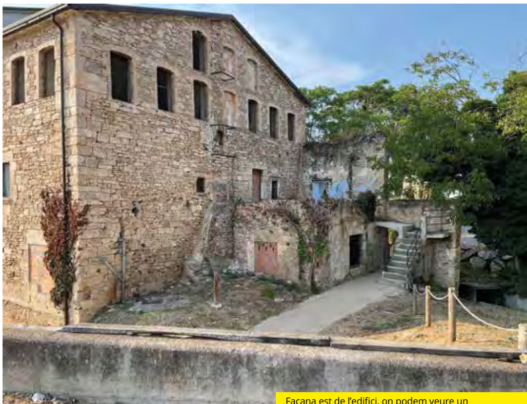
Façana est de l'edifici, on podem veure un detall del rec actual.
