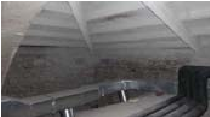
Fotografia 4: Ignifugació de l'estructura metàl·lica de la coberta de la capella.
