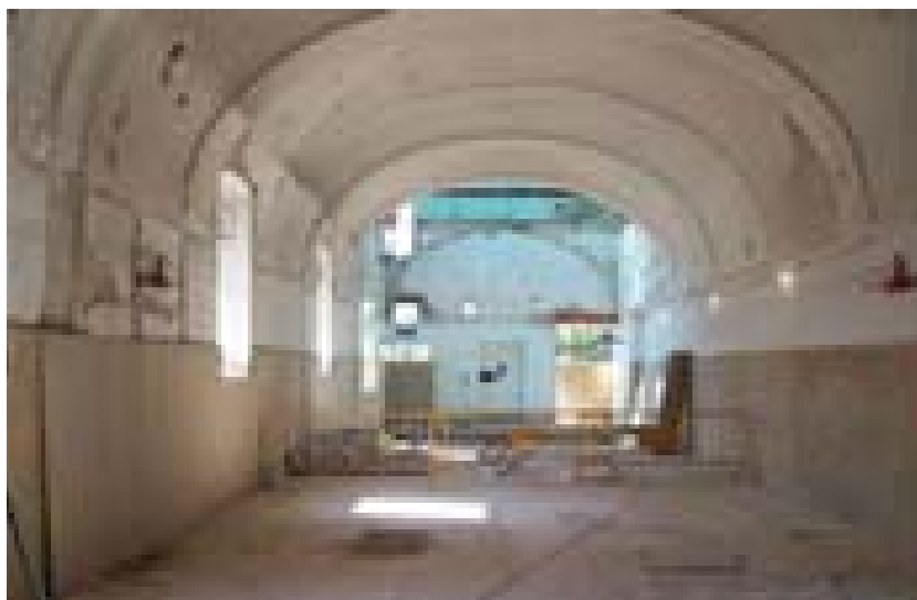
Vista de l'edifici històric durant els treballs en voltes.
