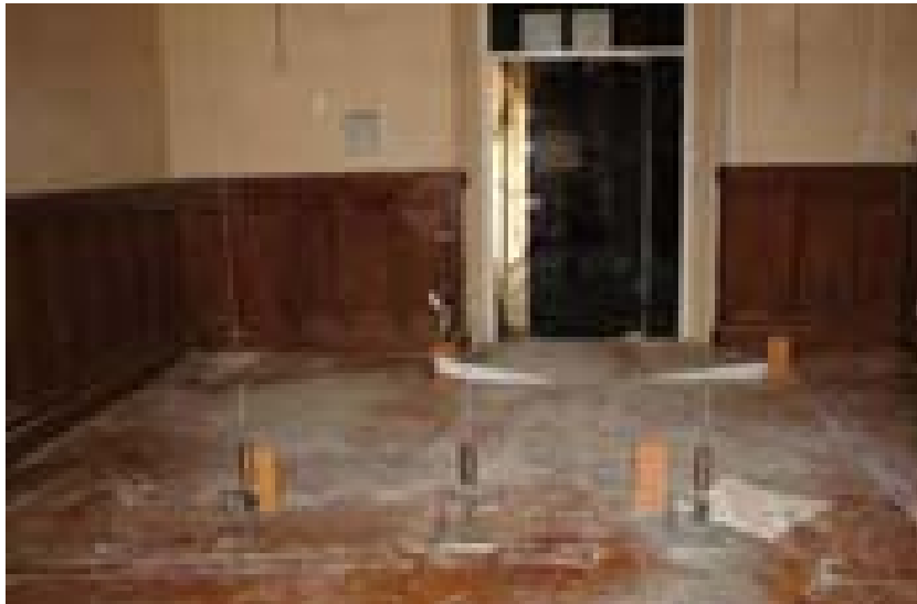
Fotografia 1: Prova de càrrega prèvia a la rehabilitació de l'edifici històric.
