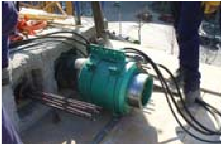
Fotografia 2: Control de l'execució del tesat del pont postesat entre l'edifici nou i el punt d'informació.
