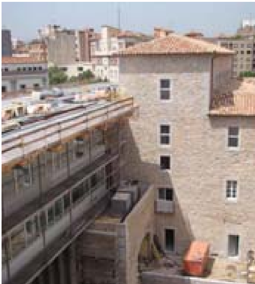
Darreres tasques a les façanes interior del pati d'edifici nou.
