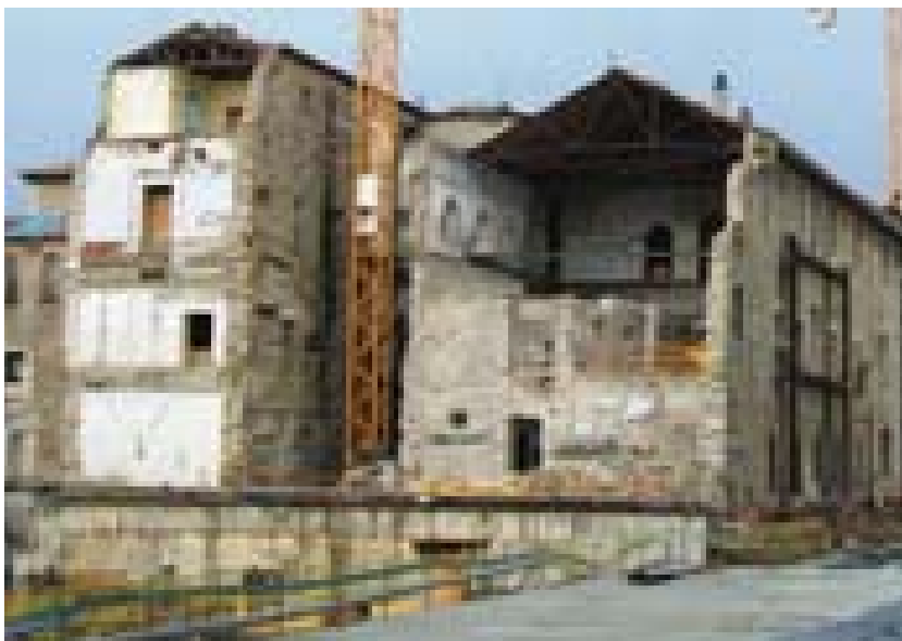
Fotografia 11. Vista de la Casa de Convalescència amb treballs de consolidació i estructura d'estintolament dels murs de pedra.
