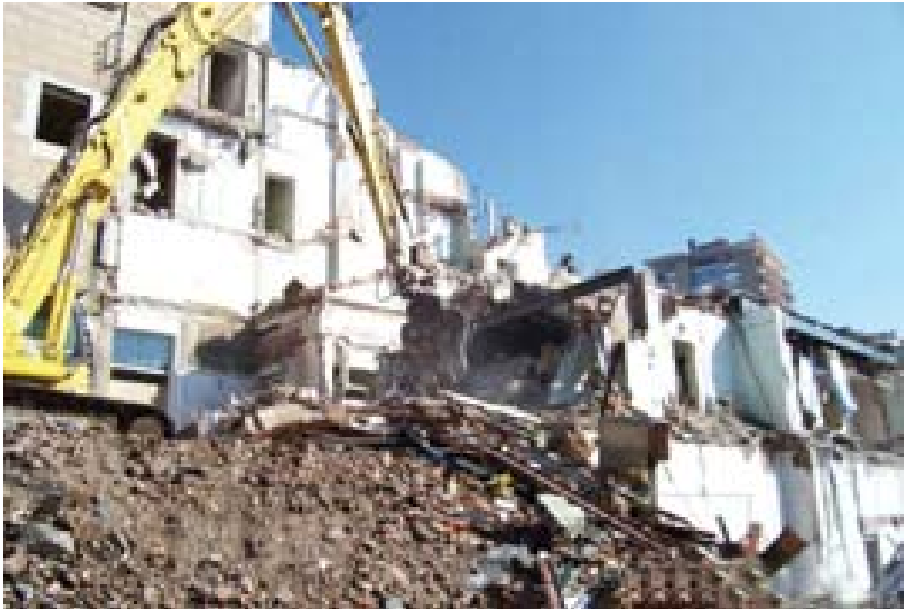
Treballs d'enderroc amb cisalles hidràuliques.
