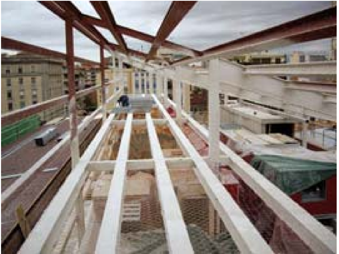
Fotografia 9. Planta tècnica per contenir les instal·lacions.
