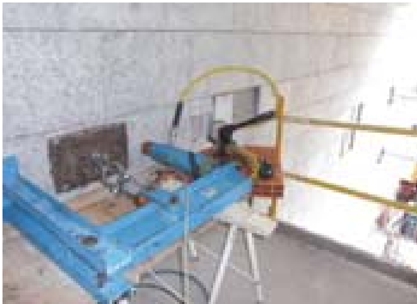
Fotografia 6: Prova d'adherència de la pedra aplacada en la façana entre l'edifici nou i la Casa de Convalescència al carrer Pompeu Fabra, a l'accés principal de l'edifici.
