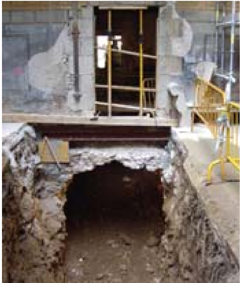
Fotografia 16. Imatge de la construcció de la galeria de serveis, on es fa evident la complicació de la seva execució.
