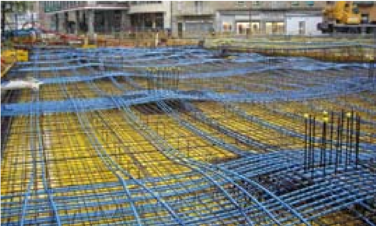
Fotografia 4. Llosa posttesada. Tendons amb beines de polietilè (color blau).
