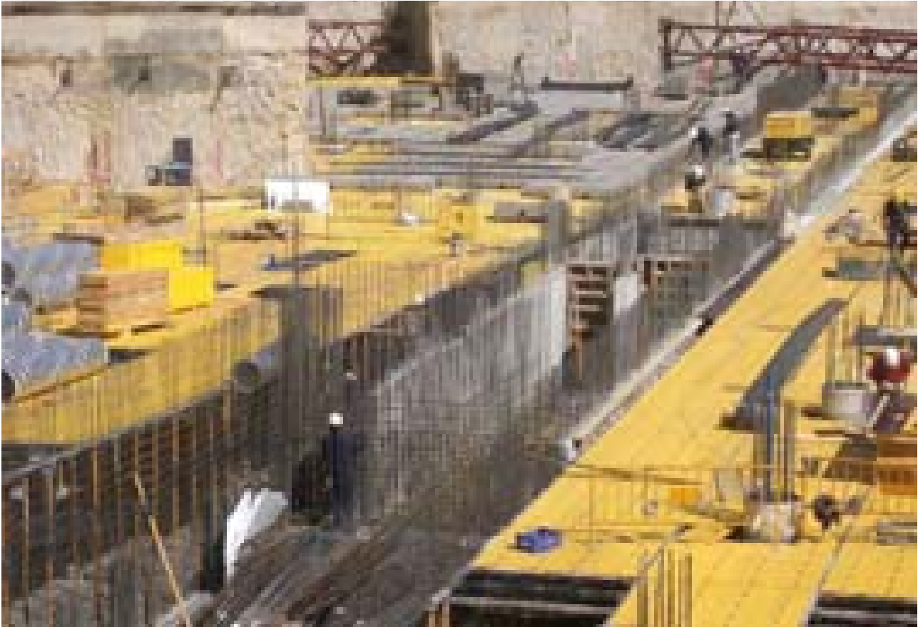
Fotografia 6. Franja de nuclis de comunicació vertical amb murs de formigó armat.
