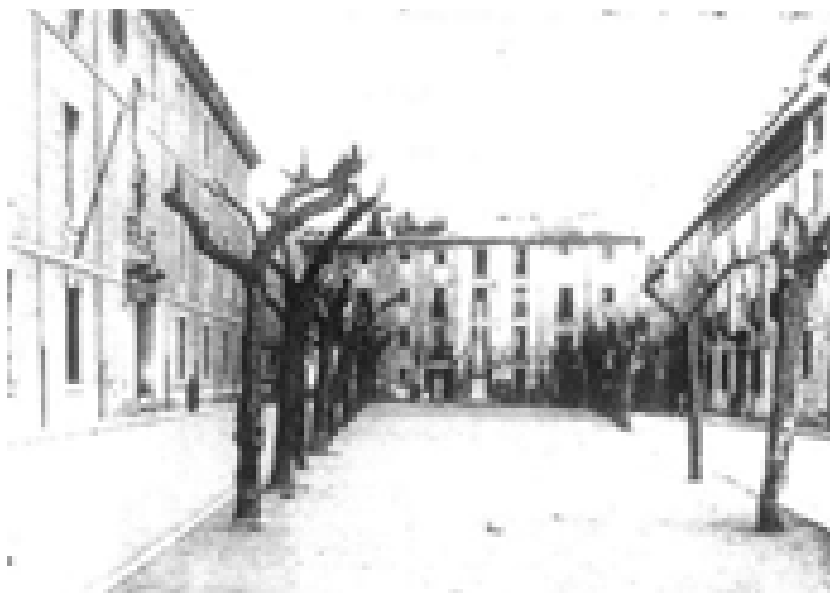
Plaça de l'hospital abans de l'enderroc de l'illa de cases entre el carrer Canaders i el del Pavo.
