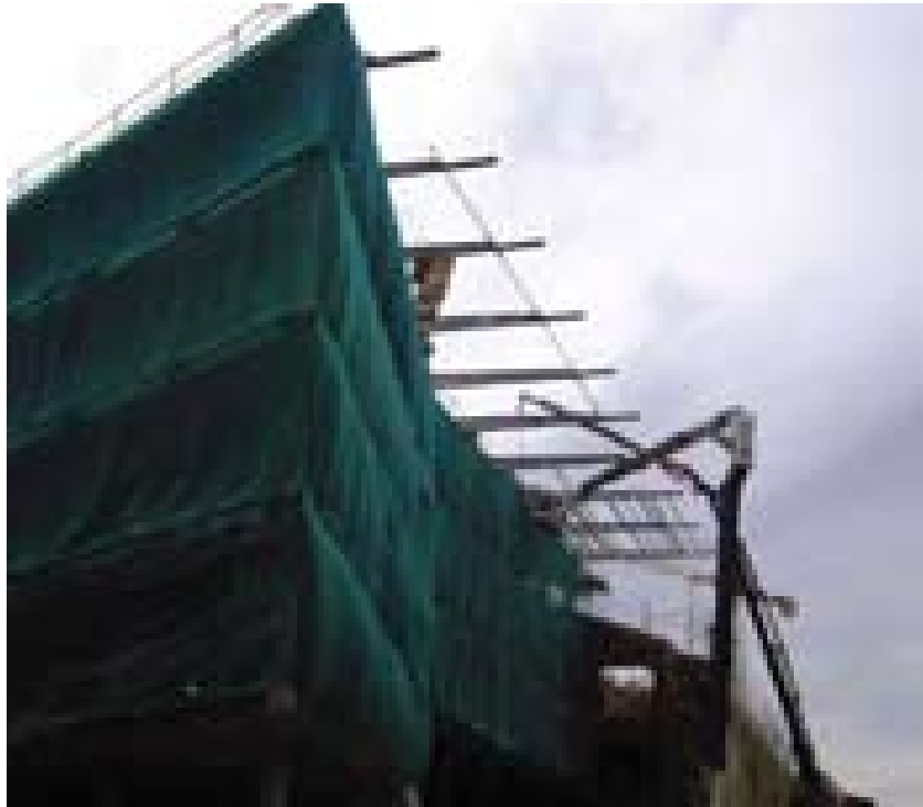
Fotografia 8. Marquesina de l'accés principal a l'edifici.
