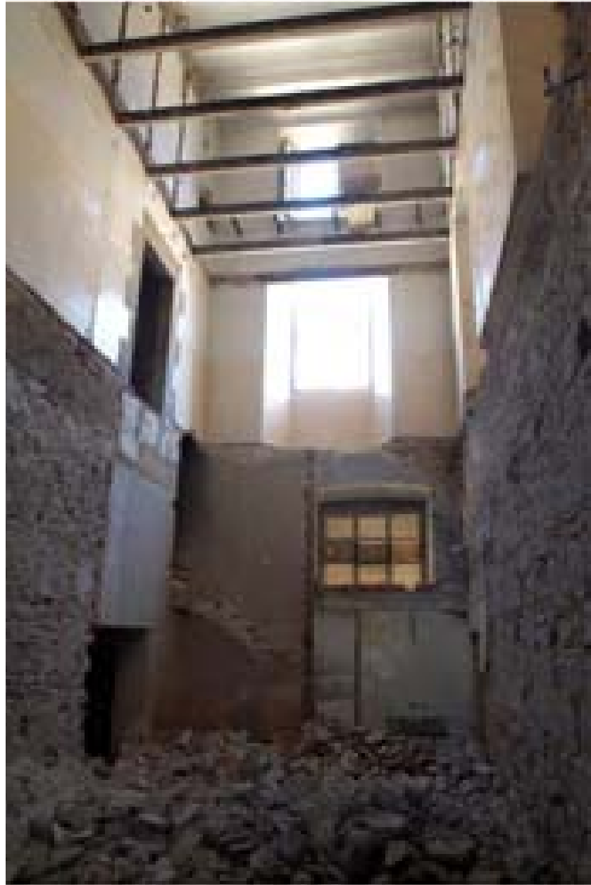
Enderroc manual de forjats a l'antiga Casa de Convalescència.
