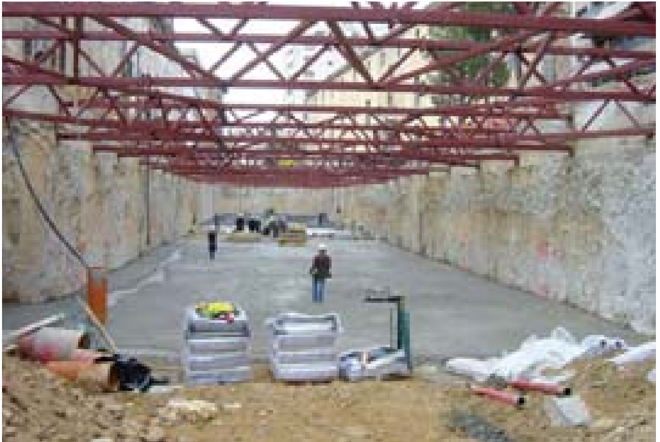
Fotografia 2. Pantalles de contenció i sistema d'apuntalament.
