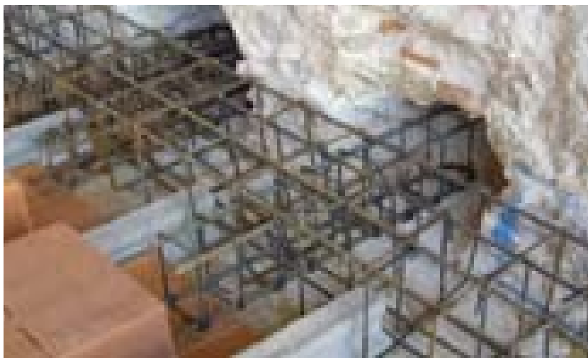
Fotografies 24. Vista de la biga paredera amb les connexions al mur.
