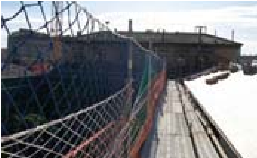
Sistema de bastida envolupant en els treballs de coberta.
