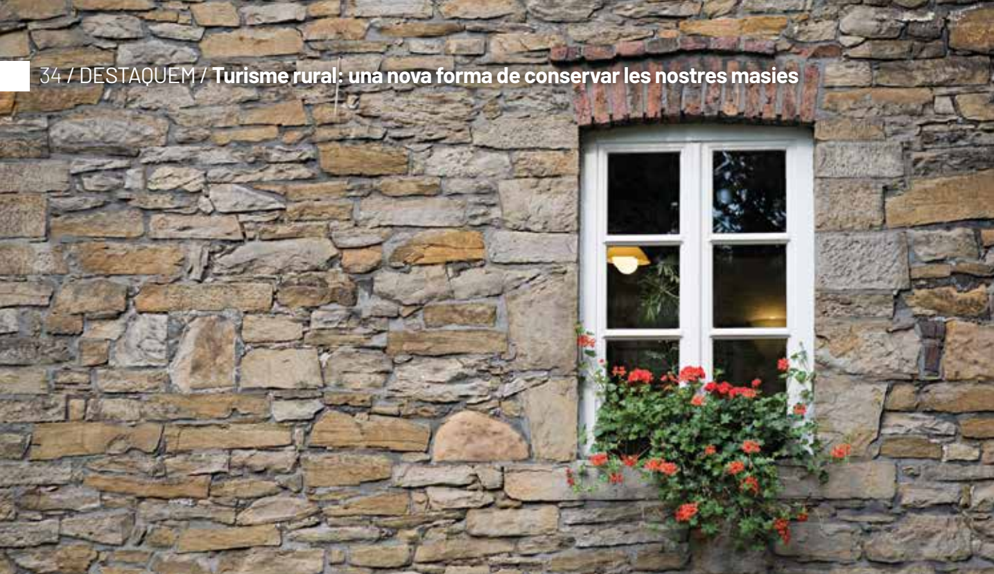
Detall d'un paredat d'una casa rural.
