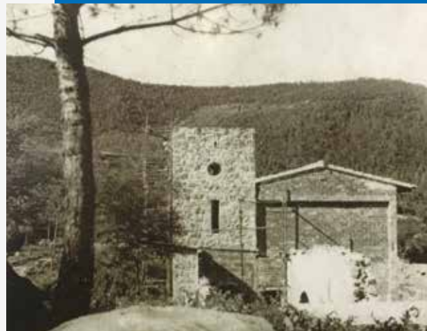
Edifici Torreó en construcció, 1965.
