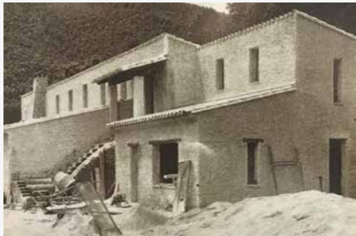
Edifici Ginesta en construcció, 1965.
