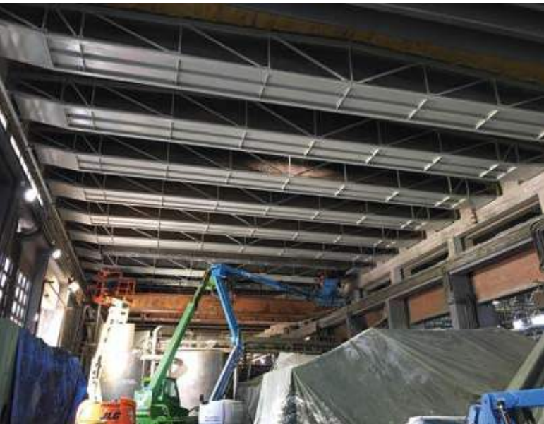
Fixació de l'element central amb unions cargolades als elements de cap de gelosia.
