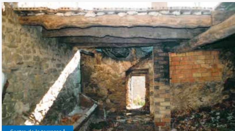
Sostre de la terrassa. 8
