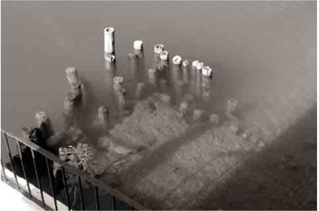
Restes de sistema palafitic de fonamentació.
