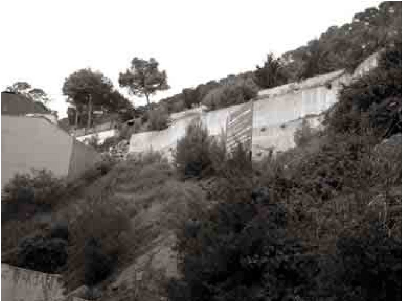
Mur de contenció a la zona de l'Hotel San Carlos.
