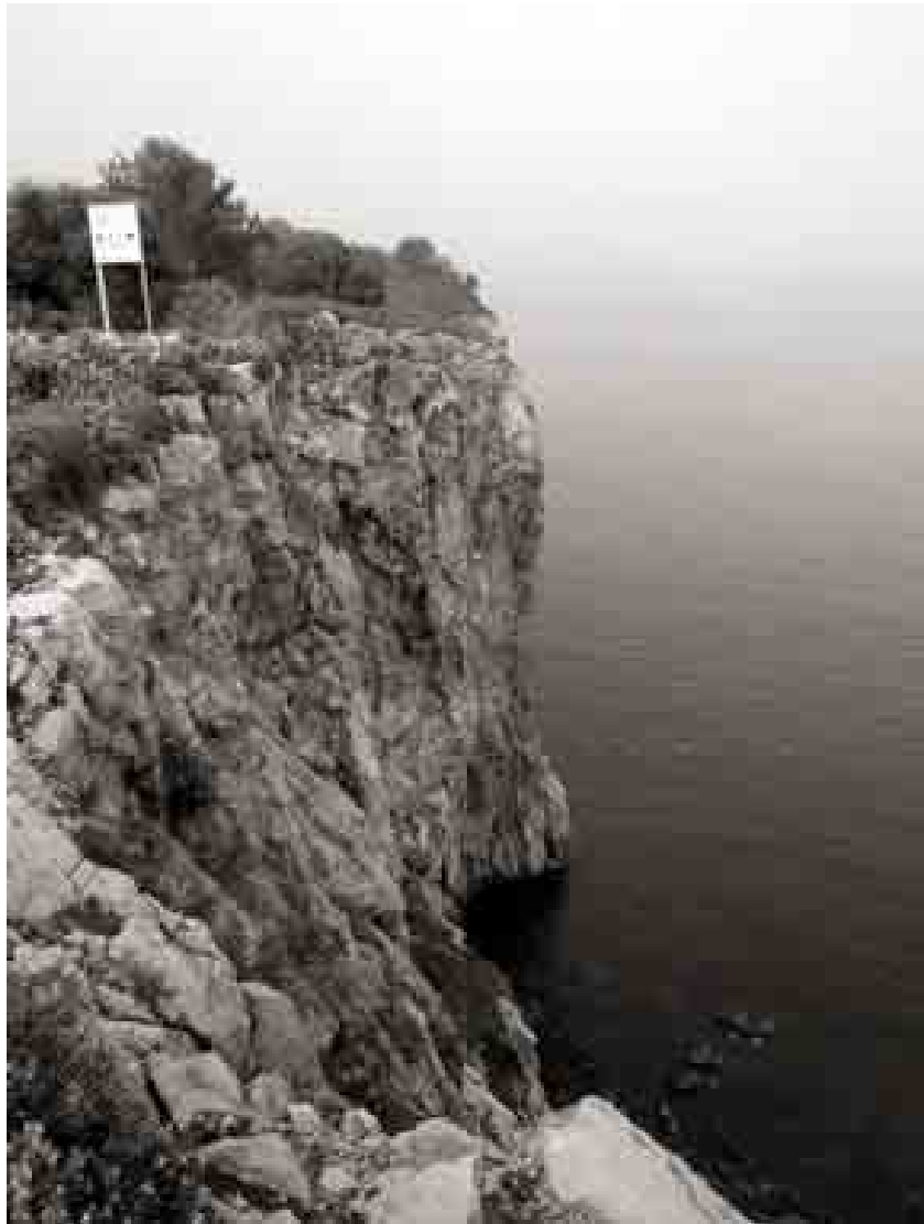
Cap de la Barra. Pareds amb risc d'esllavissament.
