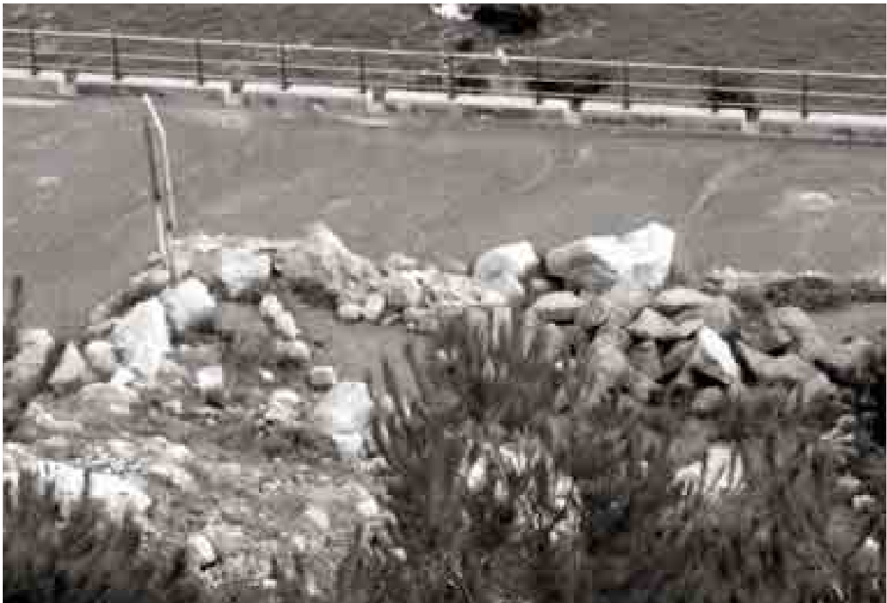
El Molinet. Roques caigudes del vessant del passeig del Molinet.
