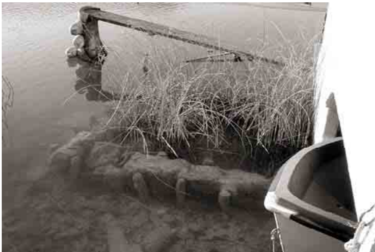
Antiga fonamentació. Solució mixta de pals i llosa.
