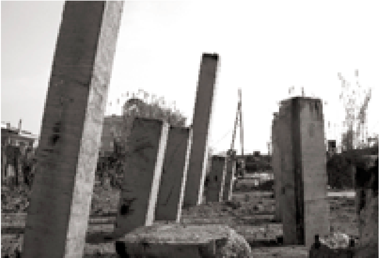
Construcció d'una nova infraestructura a la Costa Brava.
