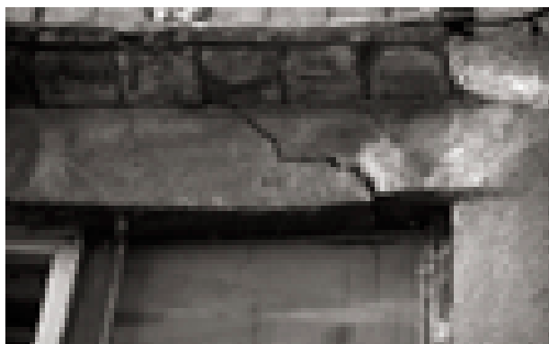
Figura 14. Ruptura de llinda.
