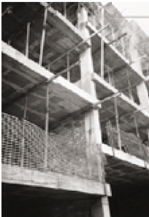
Foto 6. Pilars curts en tots els pisos d'un edifici.
