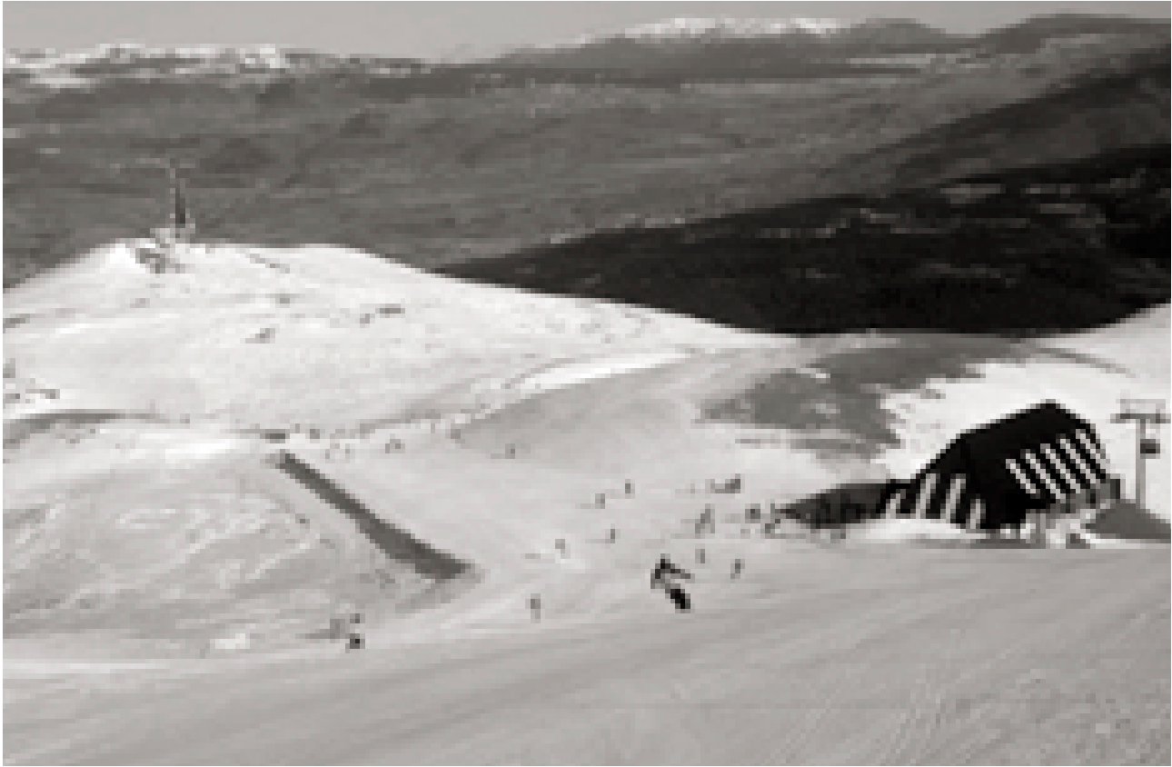
Per a la connexió entre la Molina i la Masella s'ha instal·lat un telecabina. En la imatge es pot veure l'estació d'arribada a la Masella. (Arxiu F.X.B.A.)
