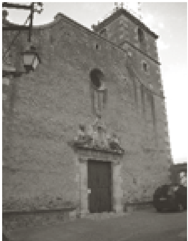
Façana principal de l'església de Torrent. (Foto: R. Ripoll).
