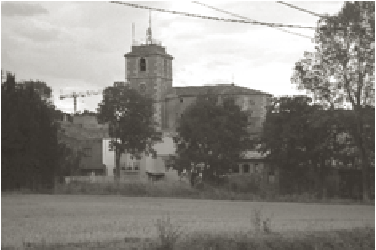
Vista general de l'església de Torrent. (Foto: R. Ripoll).
