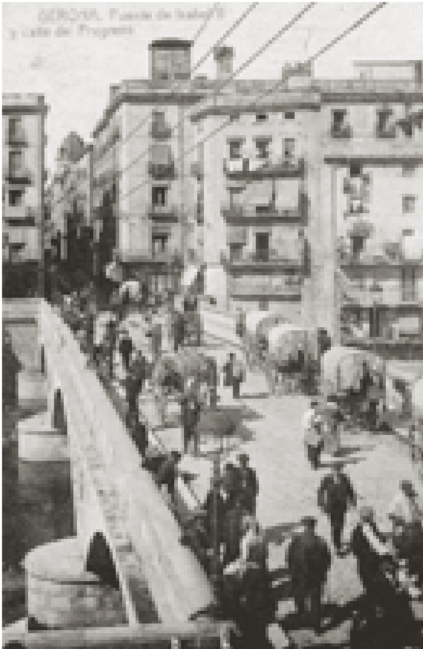
Pont de Pedra. (Arxiu: F.X.B.).
