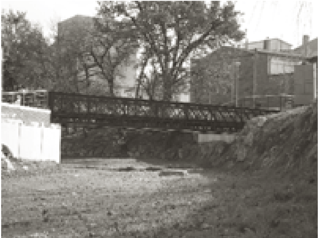
Pont Eiffel. (Arxiu: M.Y.D.).
