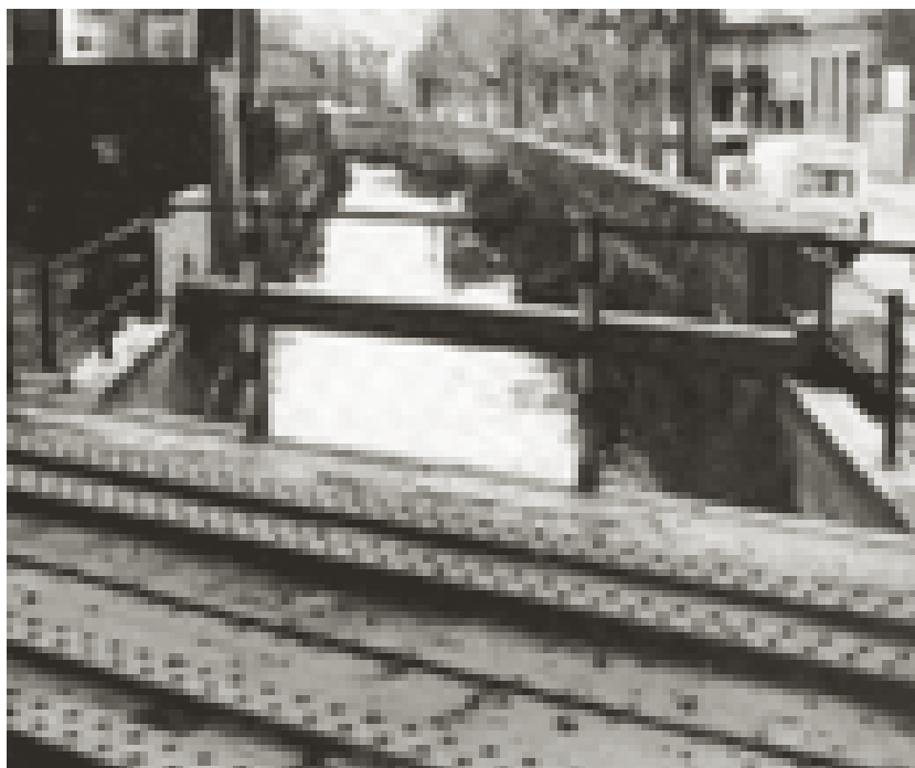
Petit pont del Ferrocarril. (Arxiu: F.X.B.).
