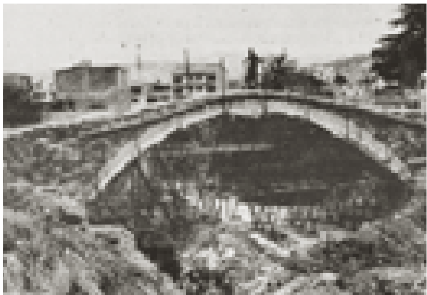
Desmuntatge del pont del Dimoni. (Arxiu: F.X.B.).
