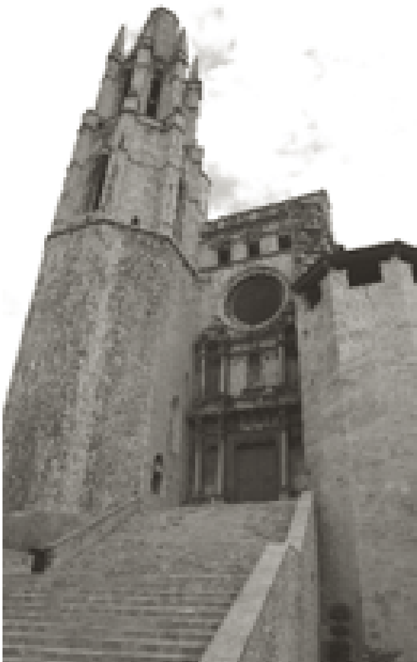
El campanar i la façana principal, abans de l'inici de les obres de restauració. (Foto: Jordi Paulí).
