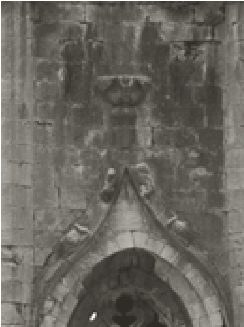
Detall d'una de les obertures del segon cos, abans de les obres. (Foto: Jordi Paulí).
