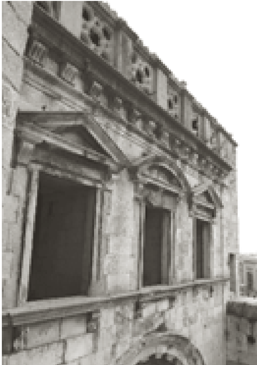
Les tres finestres superiors, abans de la restauració. Es pot observar l'important degradació de la llinda central. (Foto: Jordi Paulí).
