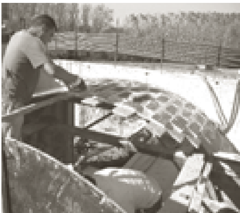
Foto 5: Exemple de construcció actual de volta de maó, realitzada per Josep Dalmau de Vidreres. (Foto: R. Ripoll)
