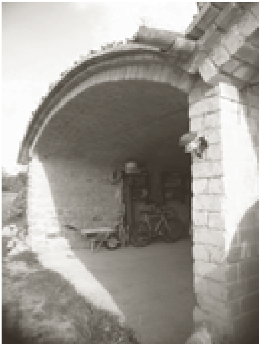
Volta de BTC d'una rosca, amb formigonat superior armat fibra de bambú. Obra a les Encies.
