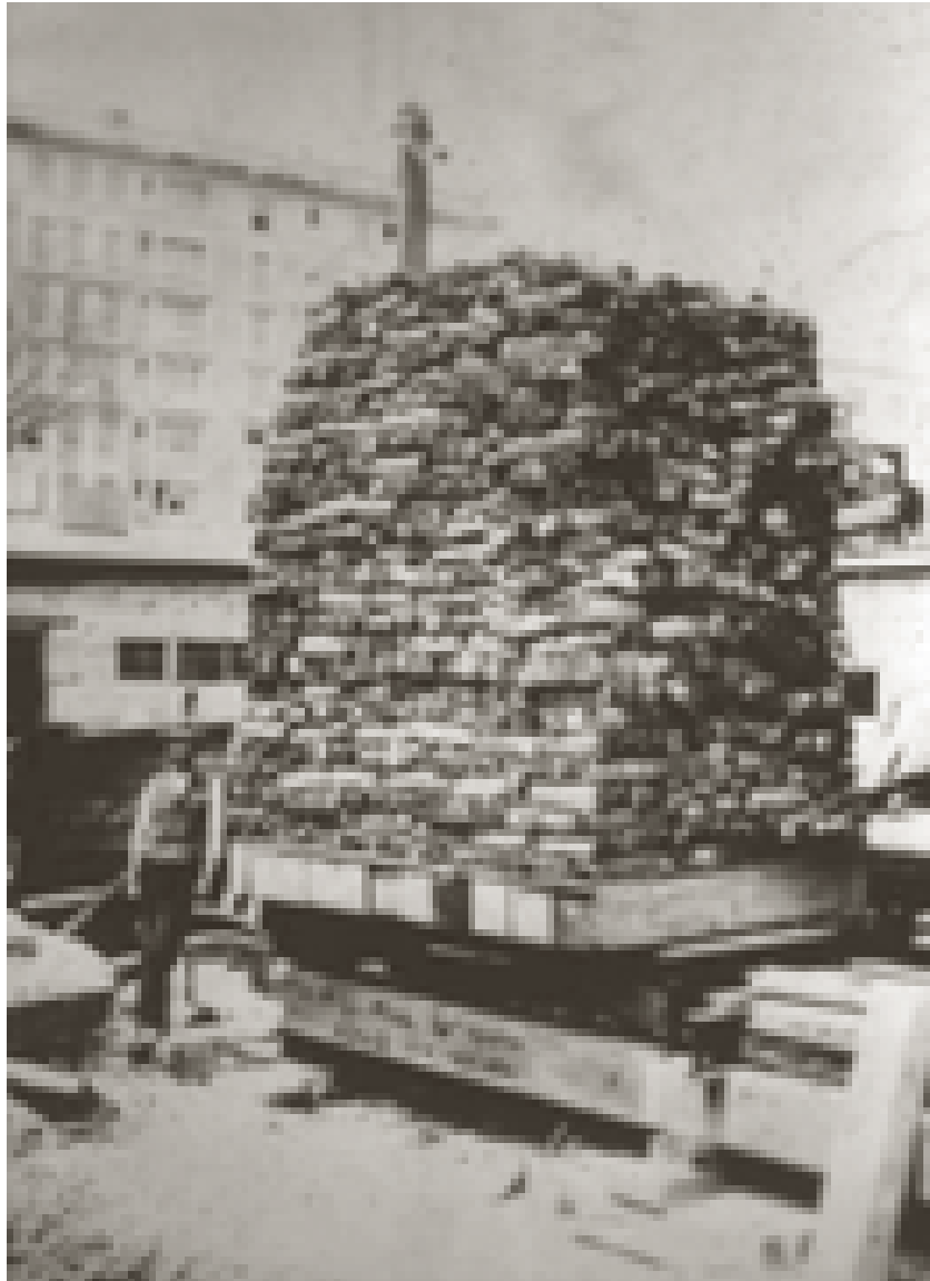
Prova de càrrega d'una volta catalana.
