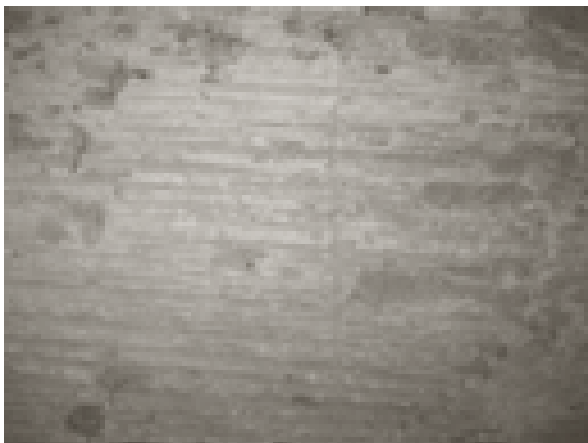
Foto 2: Exemple d'acabat de volta grassa amb les empremtes de l'encofrat de canya. (Foto: R. Ripoll)
