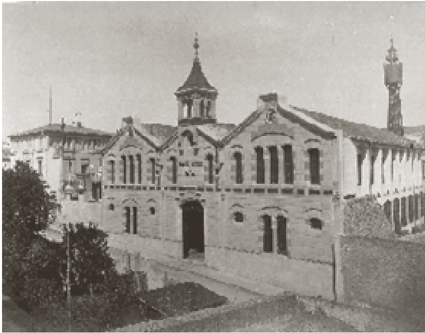
Façana de les naus de Can Mario reformada per General Guitart. Abans de 1910. Col·lecció Armstrong. Arxiu d'Imatges del Museu del Suro.
