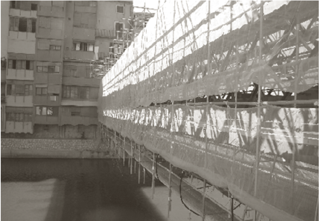
Cobriments del pont durant els treballs d'execució.
