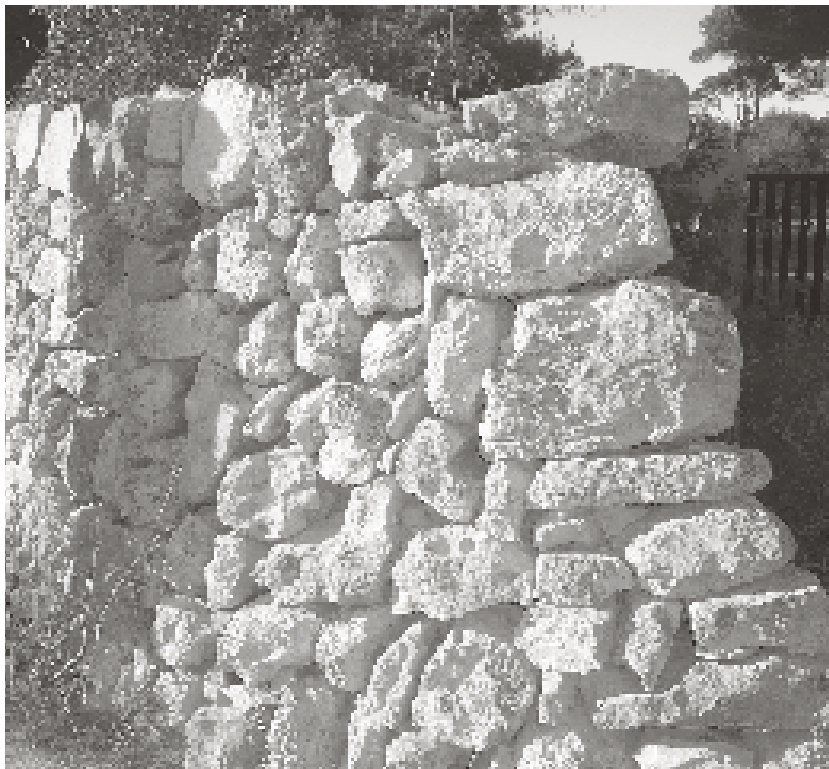
Els tancaments de paret seca són una mostra de la reutilització dels materials autòctons. (Foto: FXB).
