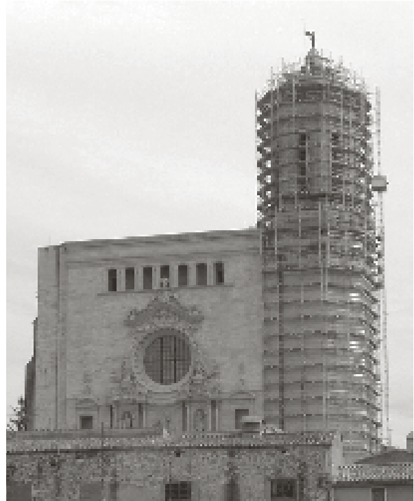
Muntatge de la bastida i el muntacàrregues. (Foto: Sònia Vergés).
