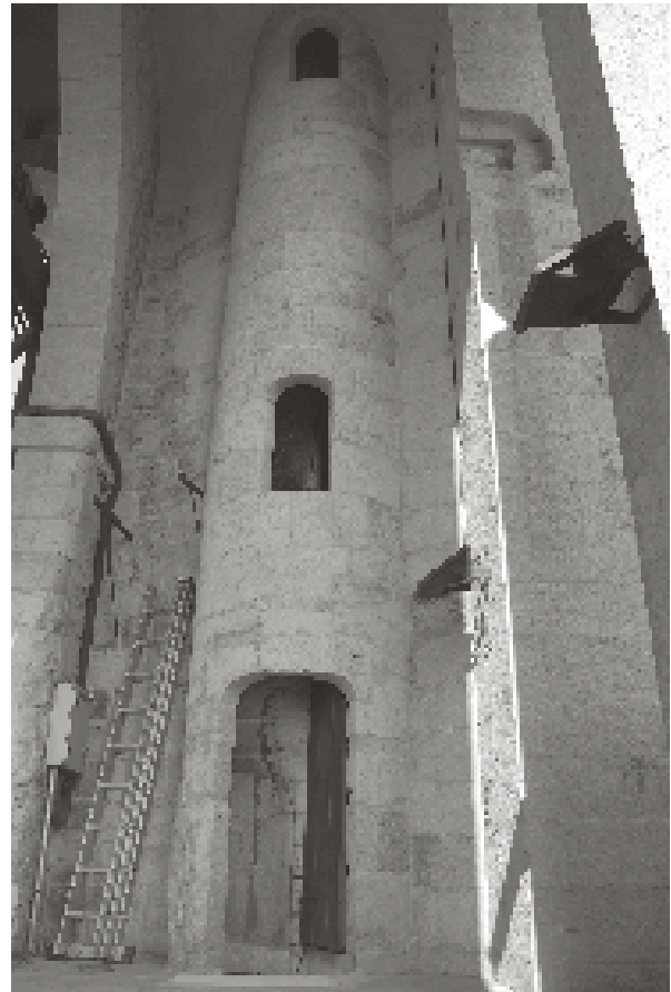
Escala que puja fins a la coberta de la cúpula. (Foto: Joan Ristol).
