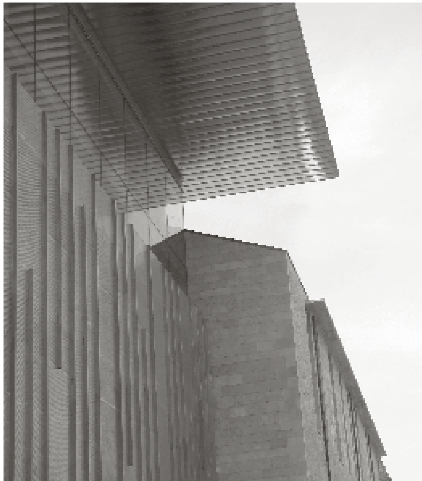
Exemple de protecció solar passiva. (Foto: Mía Masgrau).
