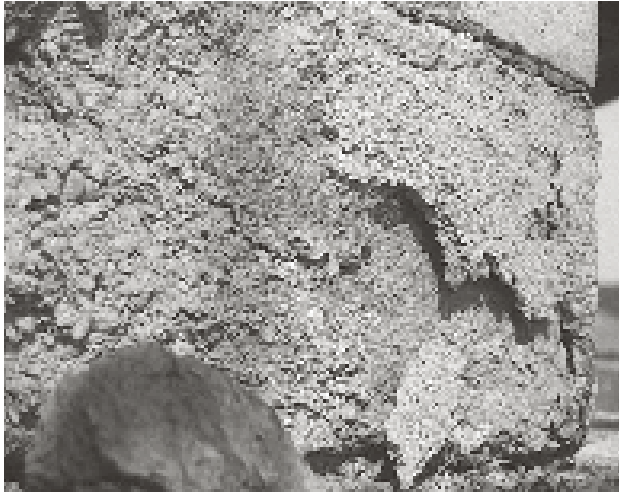
Desplacacions amb caiguda de material. (Foto: Sònia Vergés).
