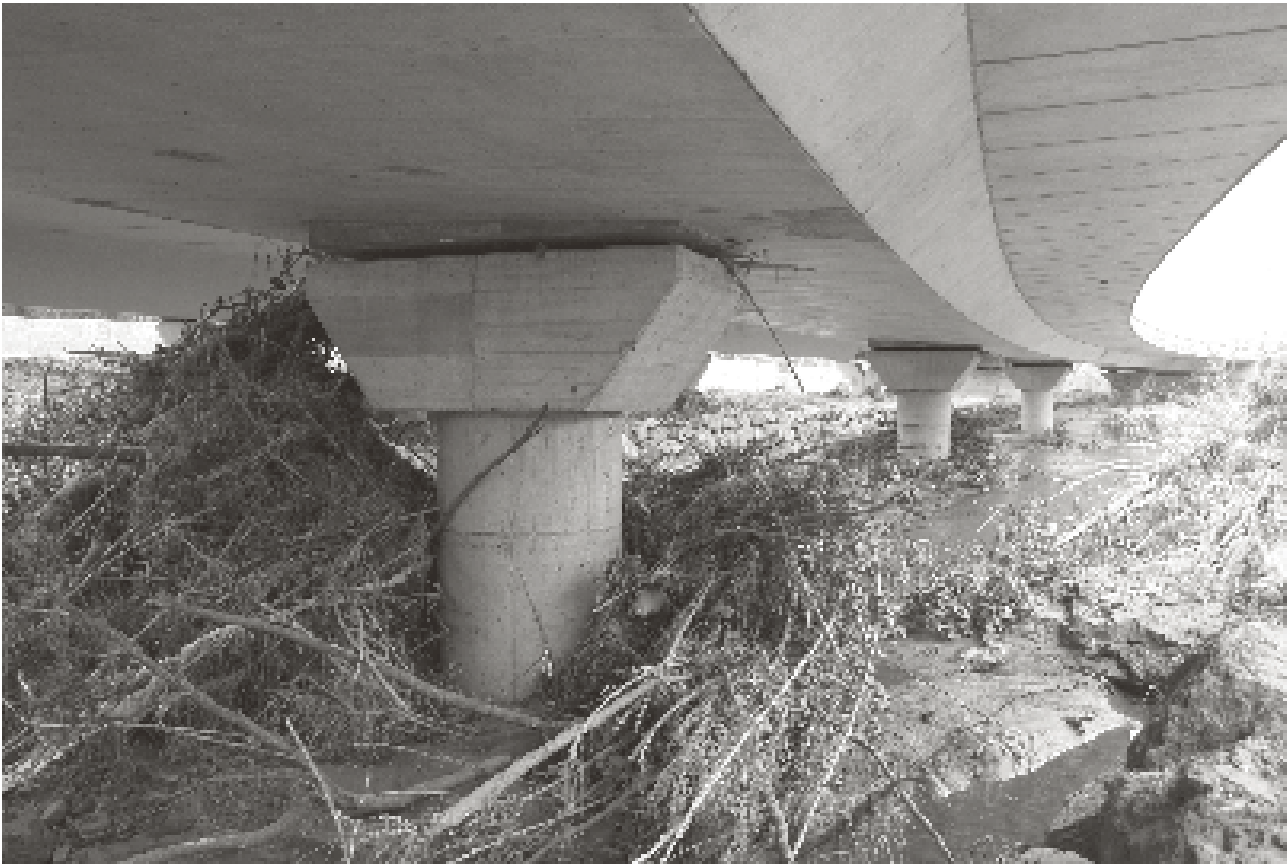
Foto 1. Les avingudes derivades d'episodis de precipitació extrema cada cop poden ser més habituals. Caldrà dimensionar les infraestructures per suportar cabals superiors als actuals. (Pont damunt el Ridaura, a Castell d'Aro. Les restes de vegetació mostren com el cabal quasi va superar la capacitat de la secció).
