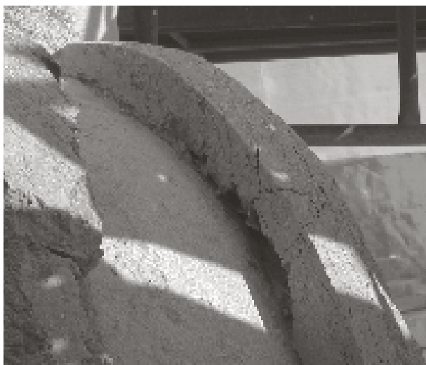
Peces arquejades del cupulí. (Foto: Sònia Vergés).
