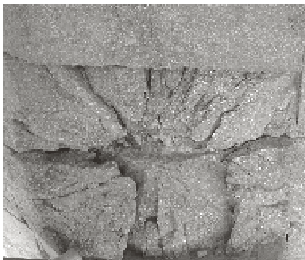
Carreu afectat per una bombarda. (Foto: Sònia Vergés).
