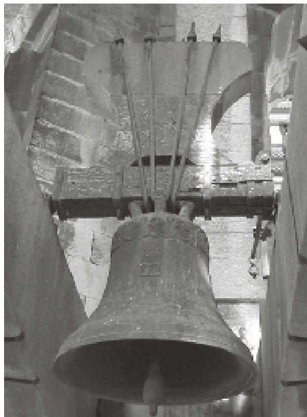
Detall d'una campana amb l'antic jou i contrapès. (Foto: Sònia Vergés).
