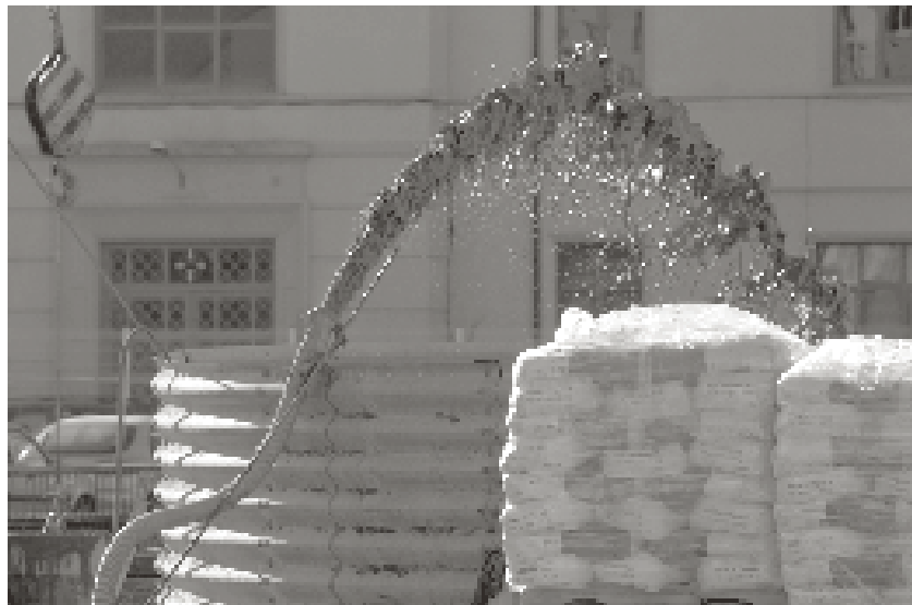
Foto 7. Bombament d'aigües subterrànies per a la construcció d'un aparcament soterrat al carrer Emili Grabit, de Girona.
