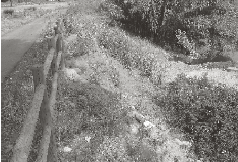
Riu Congost, la Garriga. Zona abans de la intervenció.
