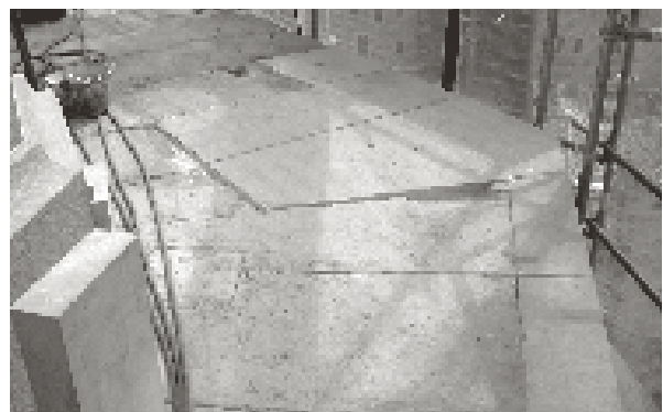
Peces acabades de substituir. (Foto: Sònia Vergés).
