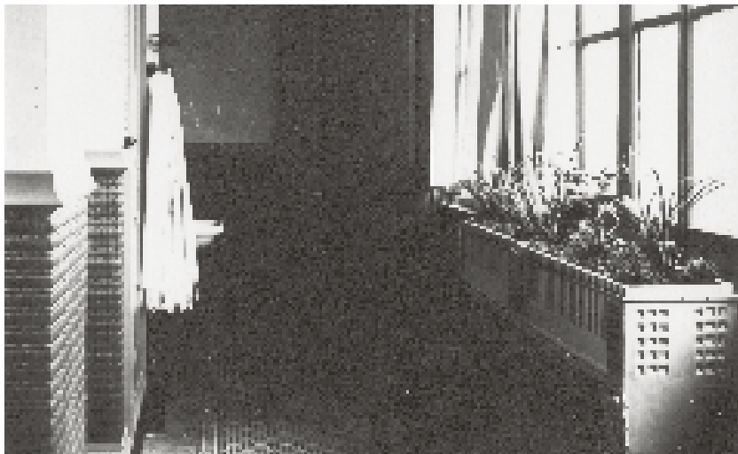
Reforma de la Casa Masó. Galeria amb jardineres. Obra de l'arquitecte Rafael Masó i Valentí (1880-1935). (Foto: Fons d'imatges de l'Arxiu Històric de la Demarcació de Girona del Col·legi d'Arquitectes de Catalunya (AHCOAC)).
