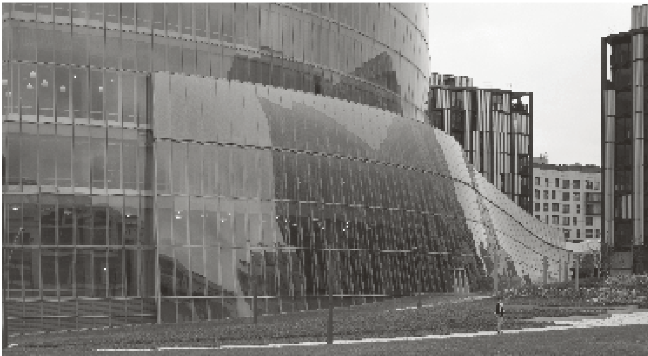
Foto 7. Façana del lobby amb el vidre corbat en fred. (Foto: Bellapart).
