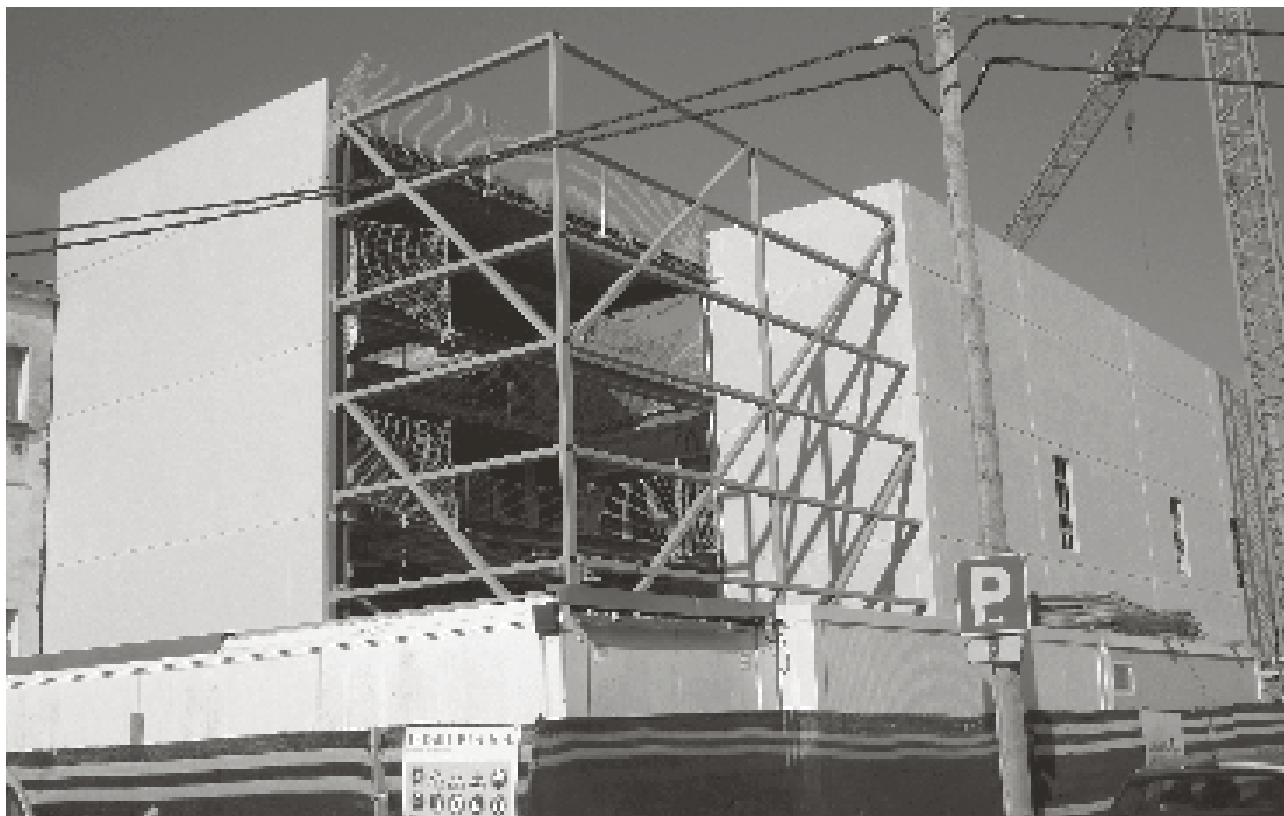
Estat general de l'edifici. (Foto: FXB).
