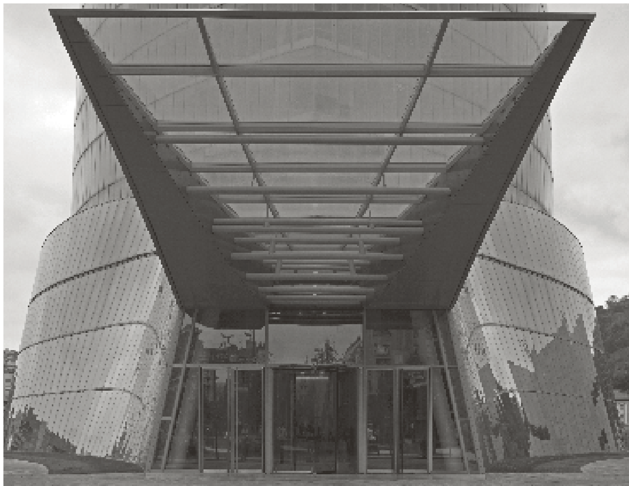
Foto 2. Vista del lobby de la Torre Iberdrola. (Foto: Bellapart).
