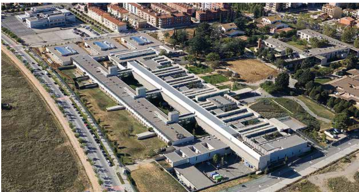
Fotografia aèria del Parc Hospitalari Martí i Julià finalitzada l'obra del nou Hospital de Santa Caterina als terrenys de l'antic Hospital Psiquiàtric de Salt
