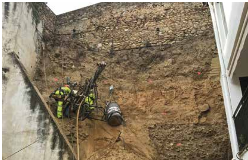
Col·locació dels bulons
