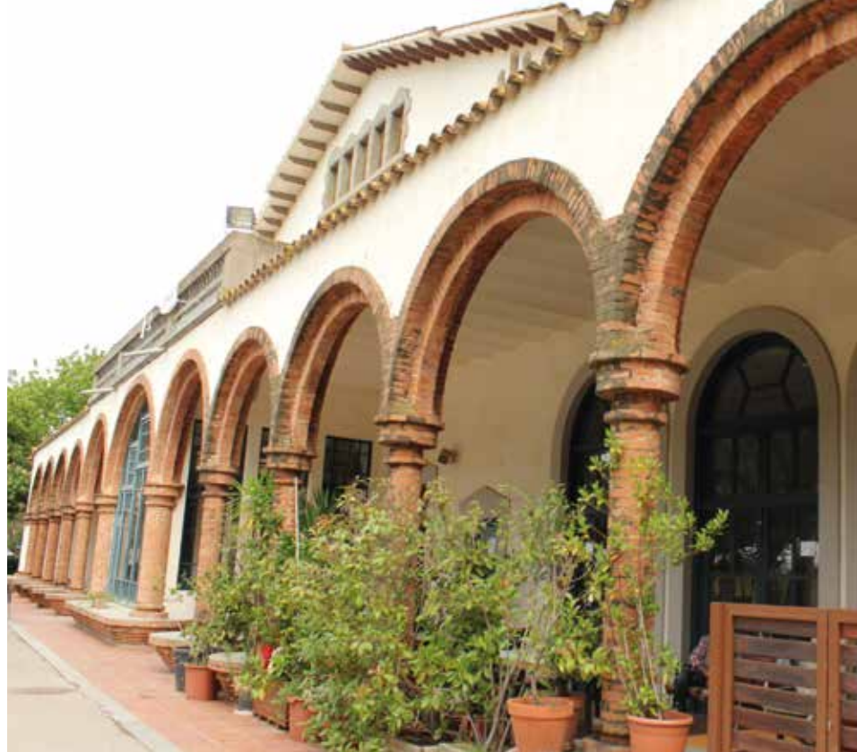
Edifici Mancomunitat 1 del Parc Hospitalari Martí i Julià. Fotografia: Anaïs Iglesias / IA
