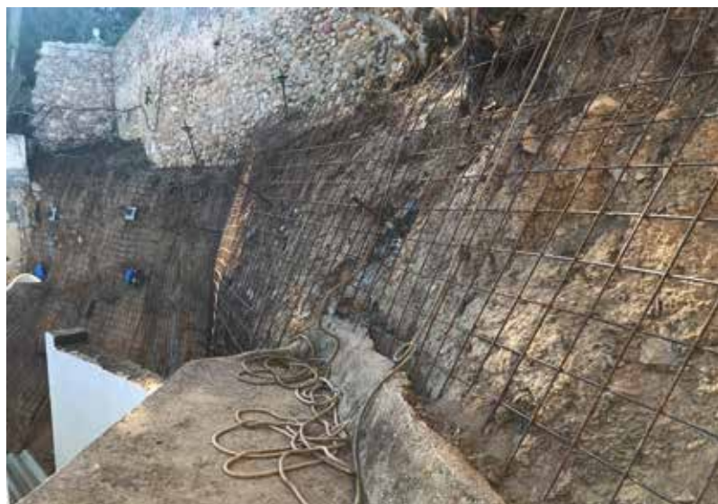
Bulons i inici de la malla
