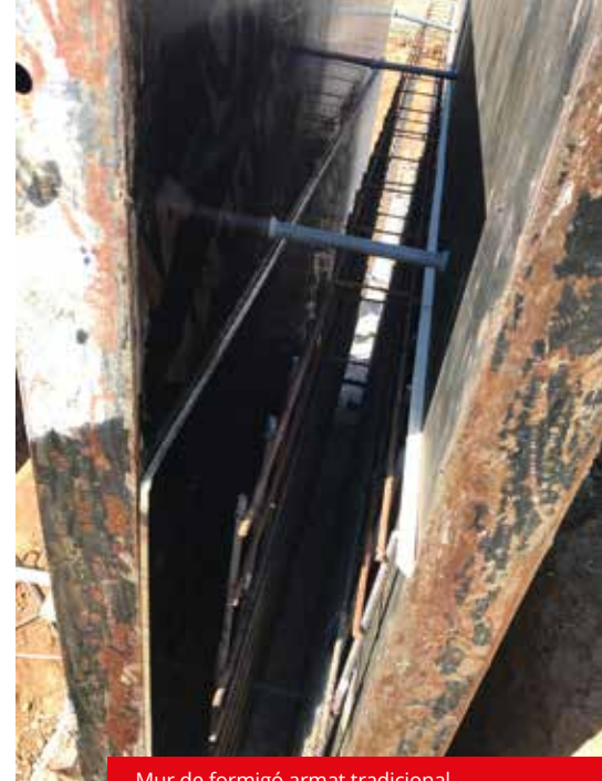
Mur de formigó armat tradicional
