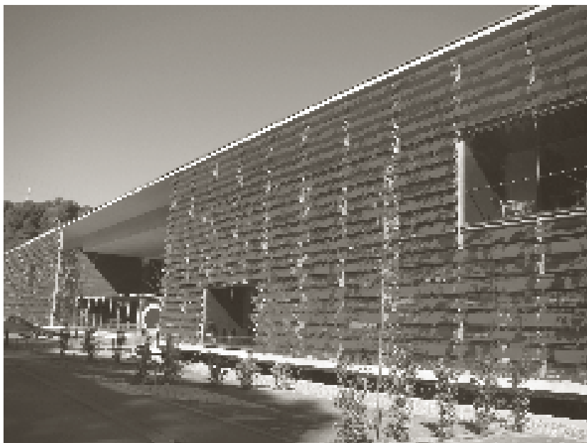
Una altra perspectiva de l'edifici. (Foto: MMV).
