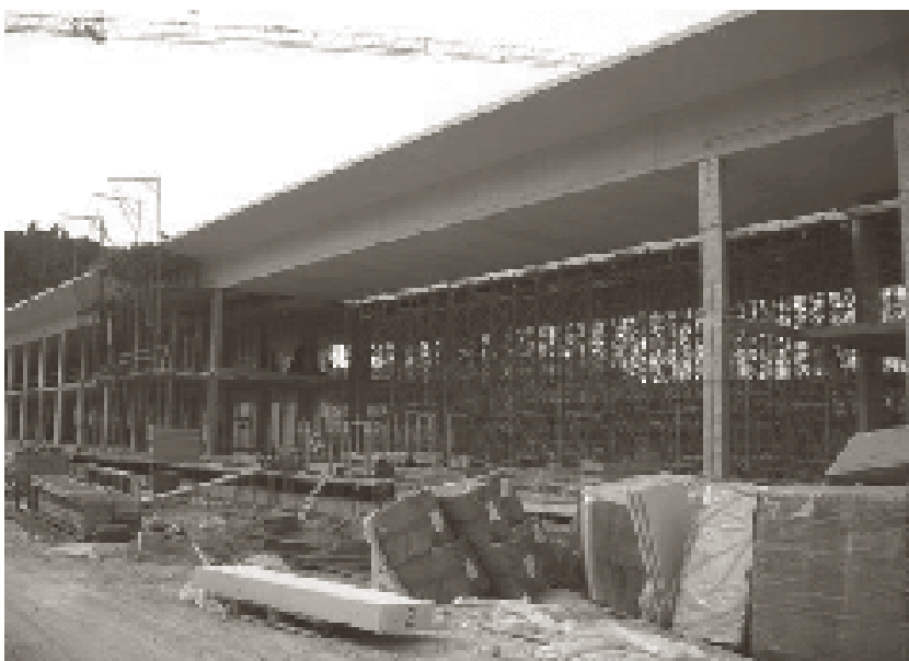
Fotografia 3: Doble espai central de 24 m de llum.
