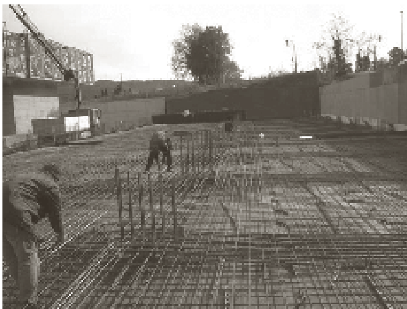
Fotografia 1: Posttesat en la direcció transversal i armat en la direcció longitudinal.
