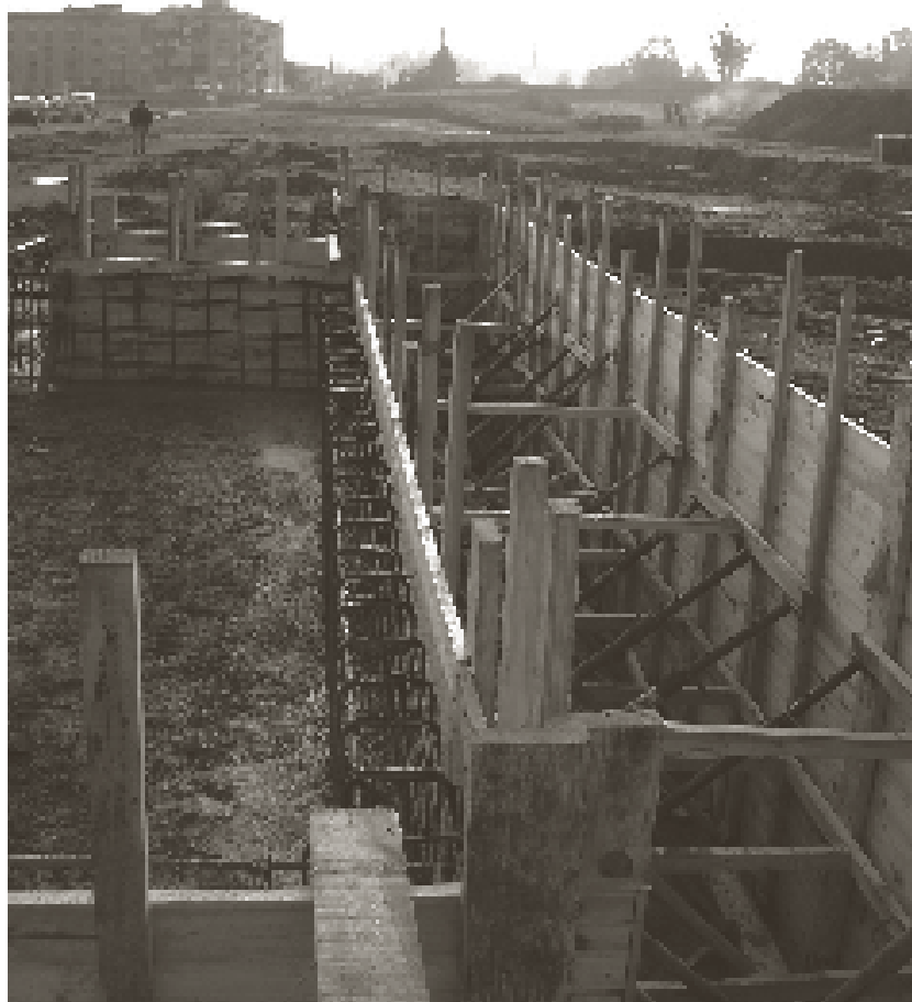
Encofrats a una cara de murs de contenció en galeria soterrània d'instal·lacions. (Foto: Narcís Cebrià).
