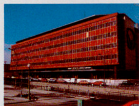
Santa Eulalia, 236-242 HOSPITALET DE LLOBREGAT (Barcelona)
