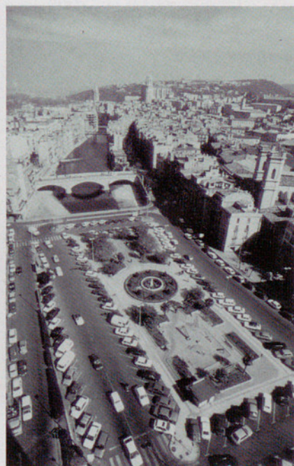
L'anomenada "plataforma" de la Pl. Catalunya compleix una funció vital pel trànsit de vehicles i vianants.
