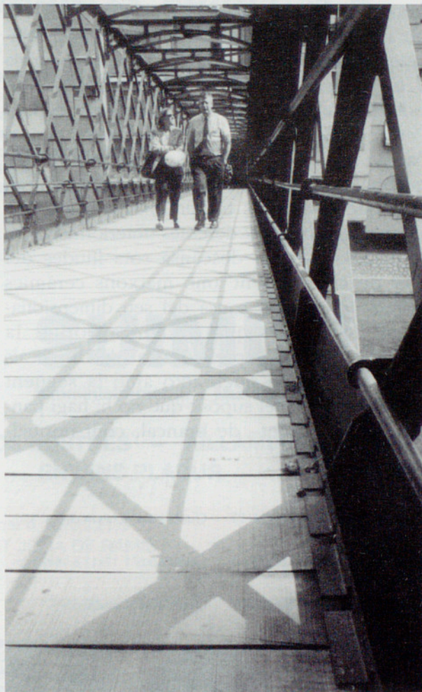
Vista del paviment de fusta de quebratxo utilitzat al pont de "les Peixateries Velles" de Girona
