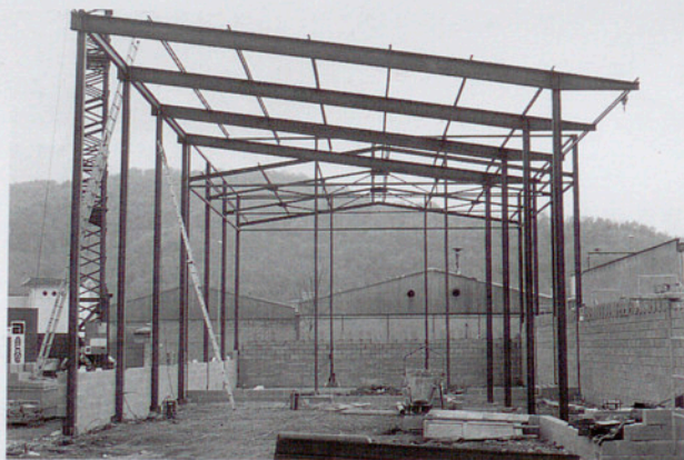
Estructura bàsica d'una nau industrial.
