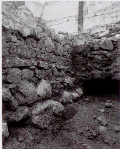
Vista de la muralla al descobert.
