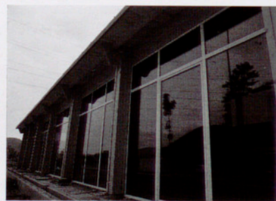
Visió de la façana principal.
