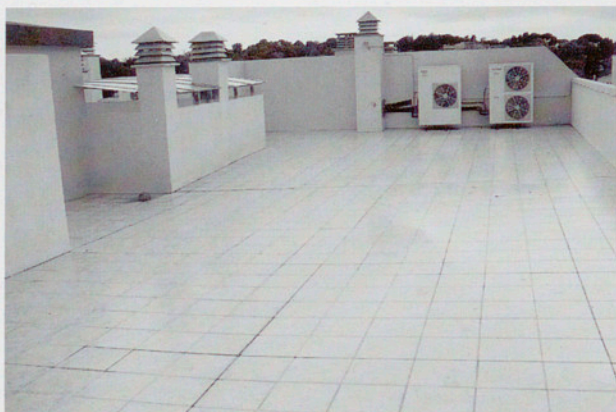
El manteniment de les cobertes planes és bàsic per a la durabilitat de l'edifici.
