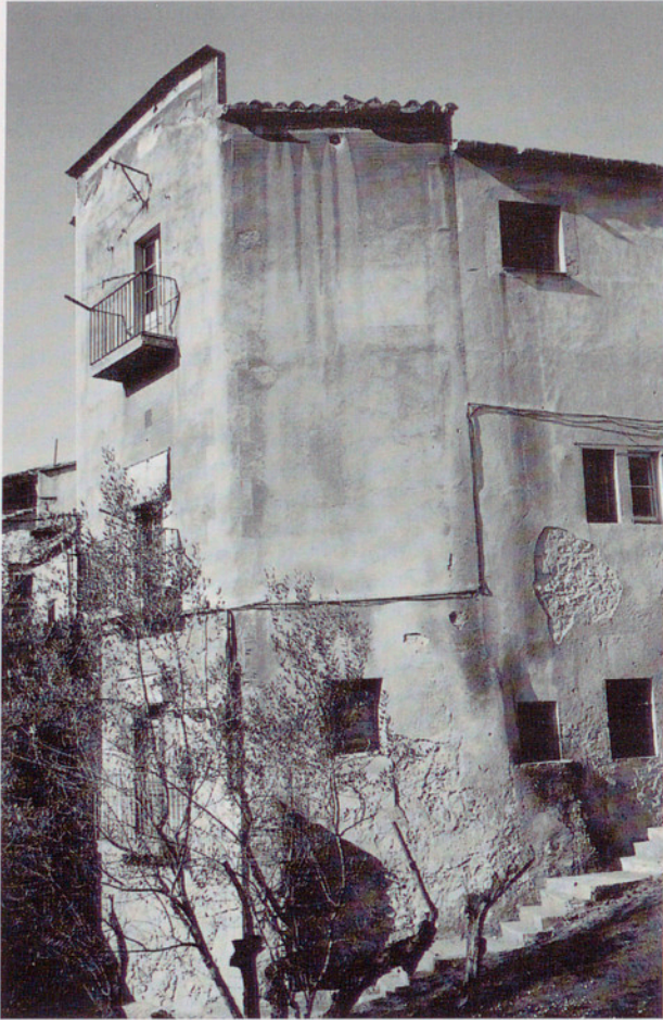
La falta de manteniment de les façanes provoca l'envelliment ràpid dels immobles. (Foto: F. X. B.)
