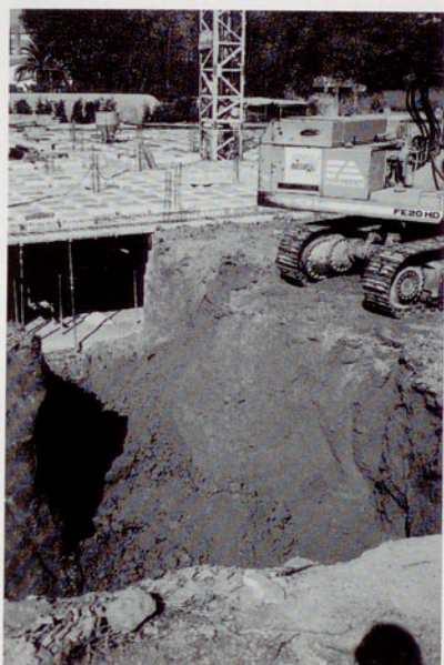
Durant una excavació cal assegurar un talús per evitar despreniments. (Foto: S. A.)
