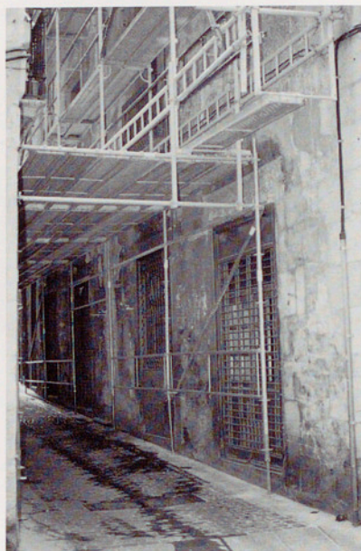
La protecció dels vianants és bàsica en les obres urbanes. (Foto: F. X. B.)
