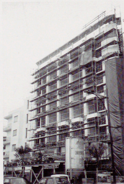
Una bastida amb baranes dóna seguretat en el treball. (Foto: S. A.)
