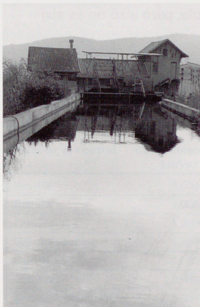
Canal d'alimentació en una central hidroelèctrica. (Foto: Carme Parramon)
