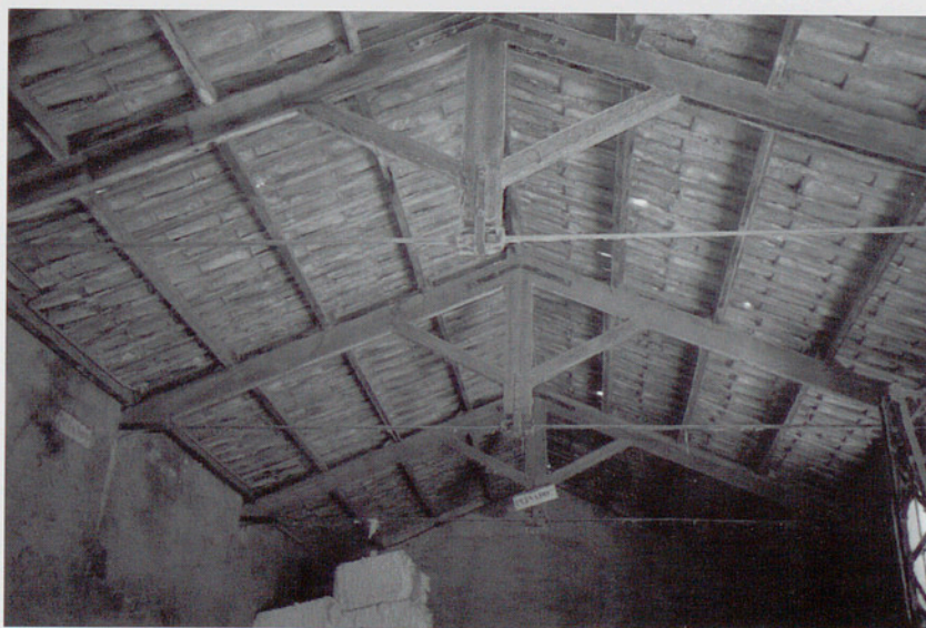
Encavallada de fusta. Fàbrica Llaudet. (Arxiu Montse Muntadas)
