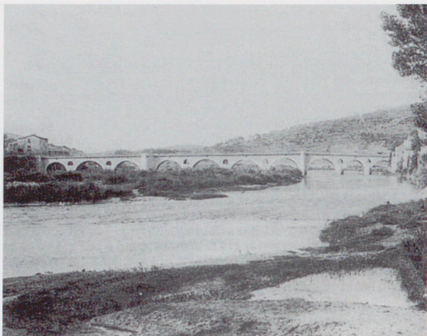
Pont del Pont Major (Girona Vella 2, de Jaume Marquès).
