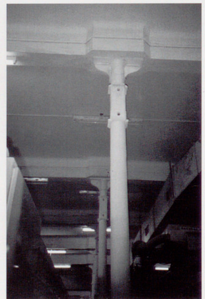
Capitells i pilars de ferro colat a la fàbrica Llaudet. (Arxiu Montse Muntadas)
