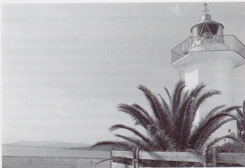
D'aquest far en depenen la balisa de la Llosa, la de les illes Formigues i els llums del port de Palamós.
