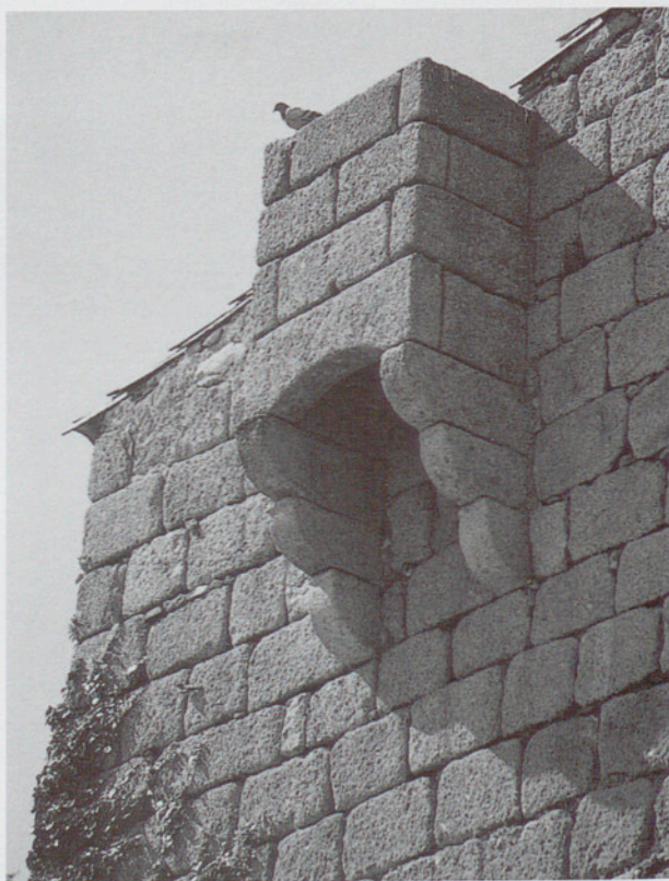
Matacà: element a través del qual es defensava l'entrada a la torre.
