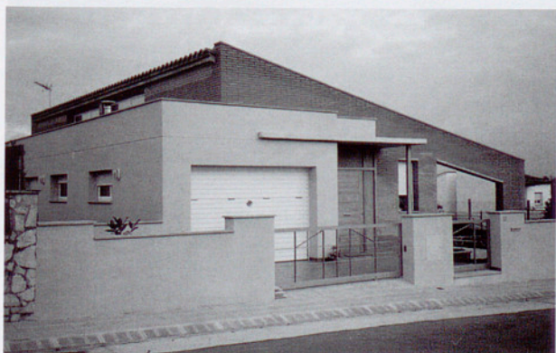
La LOE defineix la responsabilitat dels diferents agents que intervenen en la construcció. (Fotografia: FXB).
