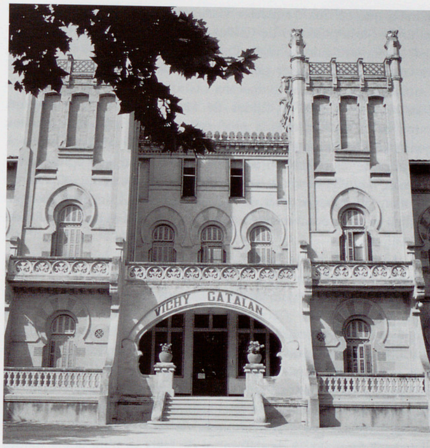
Vista frontal de l'antiga entrada. (Fotografia: Arxiu BVC).
