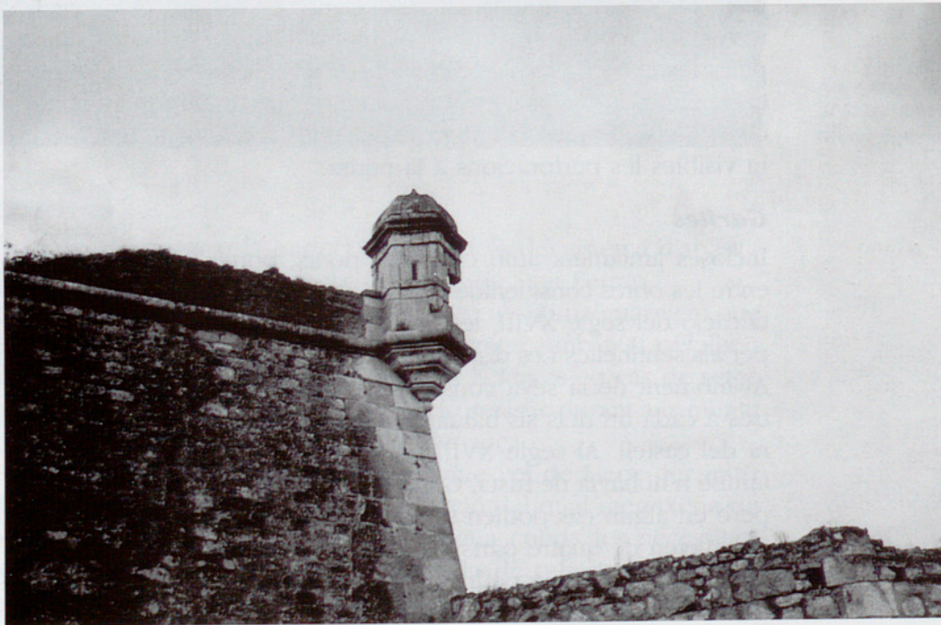
Vista d'una garita situada a l'extrem d'un baluard. (Foto: E. Viñas).
