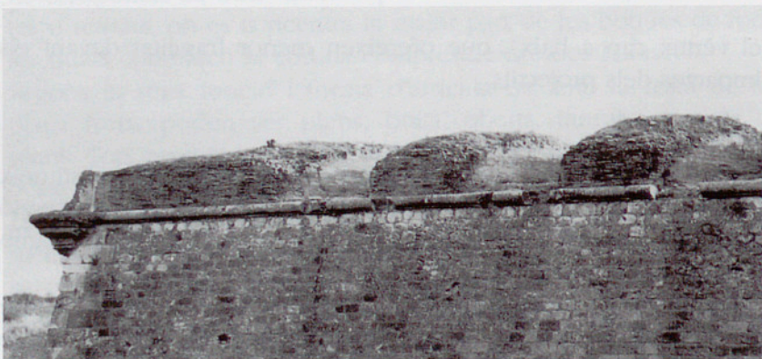
Imatge superior d'un baluard des del fossat. (Foto: E. Viñas).
