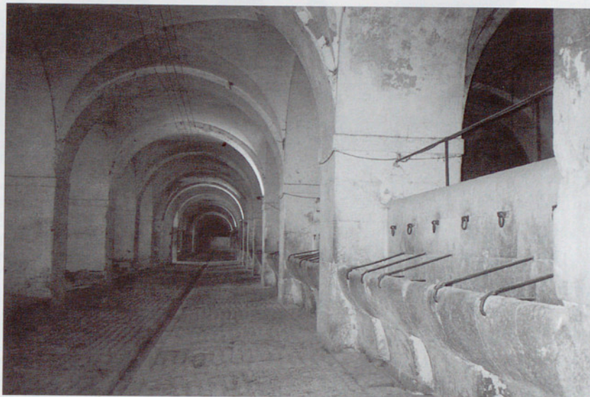
Interior de l'espai on s'ubicaven les cavallerisses. (Foto: FXB).
