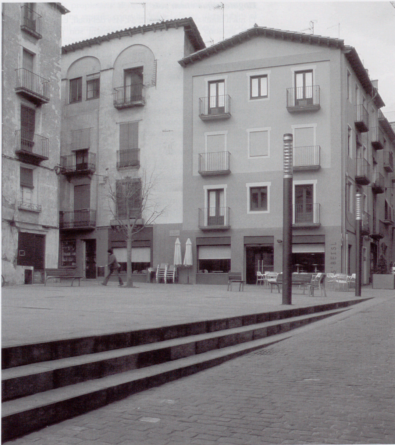
Nova plaça de la Pia Almoina. Els nous espais lliures comporten la rehabilitació dels habitatges i millora de l'entorn. (Foto: Quim Roca - AIO 2003-)
