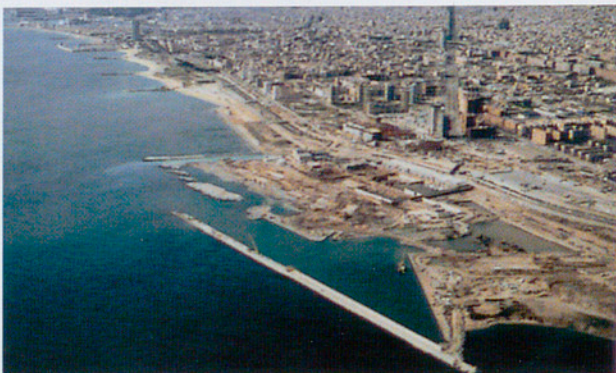
Vista aèria del futur port esportiu i de la zona de bany. Al fons s'observa la prolongació de l'avinguda Diagonal. (Foto: ILLBSA)
