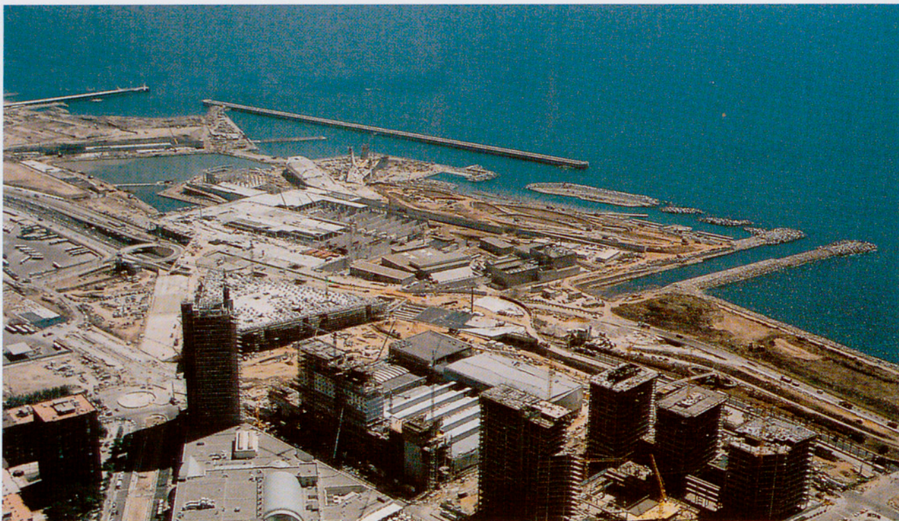
Les obres del Fòrum culminen la recuperació del mar per a la ciutat entre el Port Vell i la desembocadura del Besòs. (Foto: ILLBSA)
