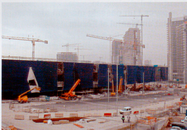
Des del mirador es pot contemplar la gran quantitat de grues i de les edificacions que s'estan construint amb motiu de la celebració del Fòrum.
